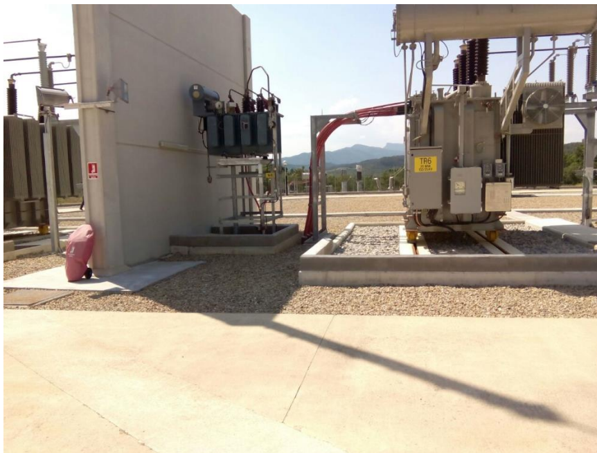
Figura 16. Mur tallafoc amb extintor mòbil
