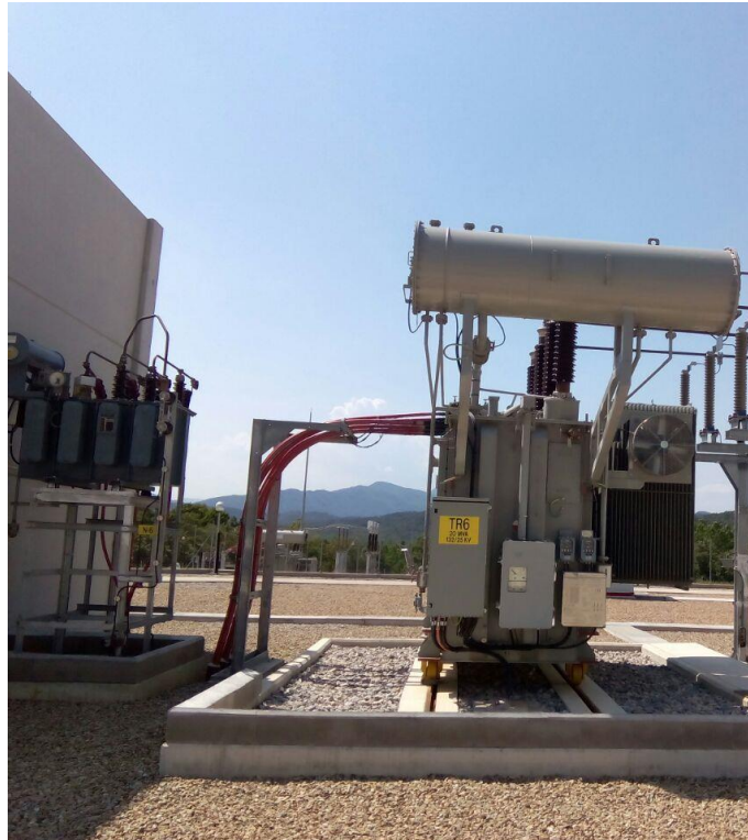
Figura 6. Transformador 40MVA 132kV/25kV (dreta) i transformador Zig-Zag (esquerra)
