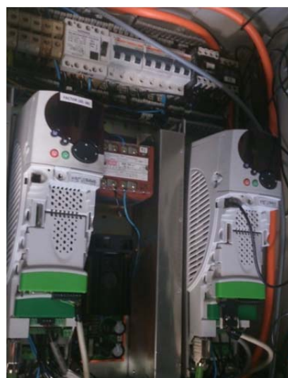
FIGURA 15. Variadors, sistema de potència i control
