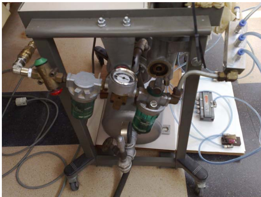
Fig. 15.: Fotografia del conjunt regulador, on es poden observar a més d'esquerra a dreta: la clau de pas, el filtre, el manòmetre, l'engreixador, el distribuïdor i els quatre ràcords.
