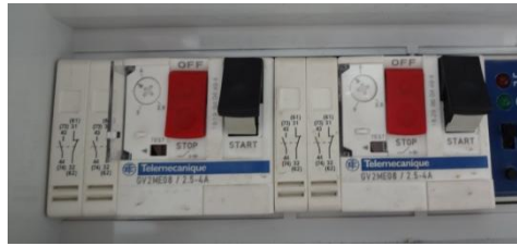
Figura 20. Panell elèctric que controla les bombes.
