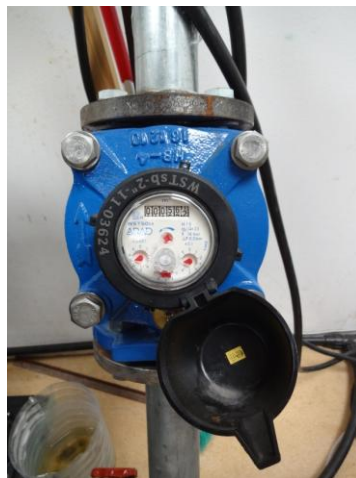
Figura 10. Comptador volumètric en línia a la canonada d'impulsió.
