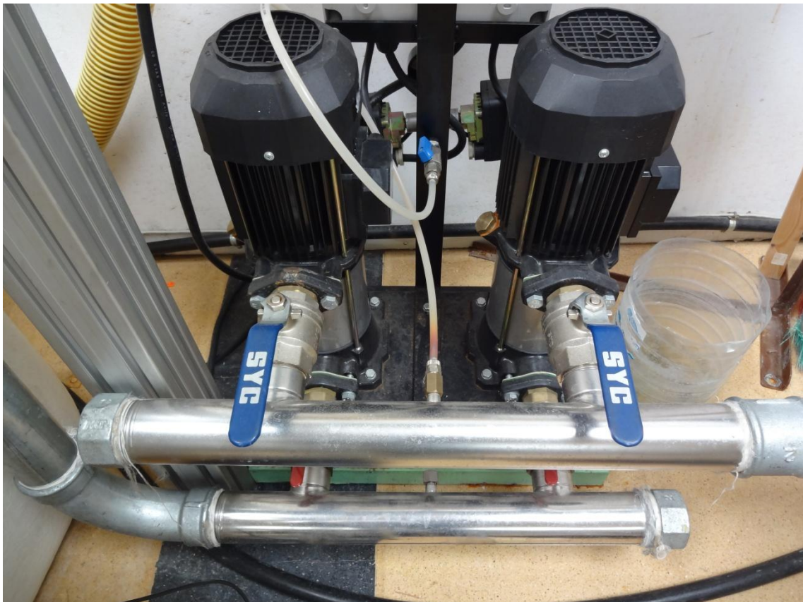
Figura 19. Les dues bombes que tenim connectades en paral·lel al laboratori.
