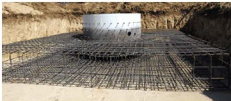
Figura 27. Cimentació en construcció d'un aerogenerador
