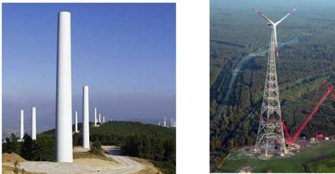
Figura 19. Torre d'acer tubular (esquerre) i torre de gelosia (dreta)
