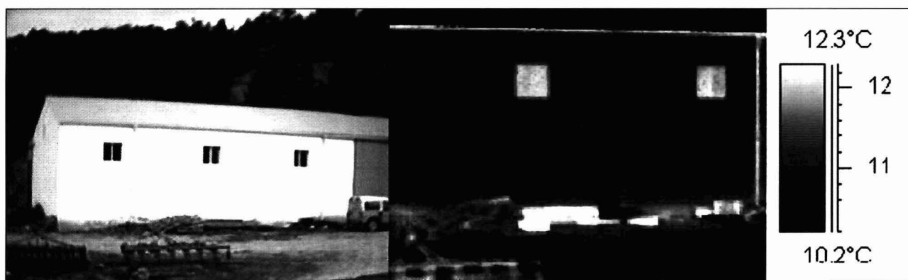
Figura 3.- Nave agrícola. La termografía revela la presencia de una junta de importante espesor en el muro. Tomada al amanecer.
