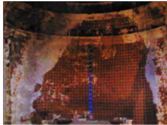
46 i 47. Imatges tèrmica i digital de l'interior de la façana Est de l'església de Sant Julià de Vallfogona.
