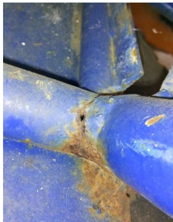
Figura 63: Estat soldadura unió de tubs xassís preliminar
