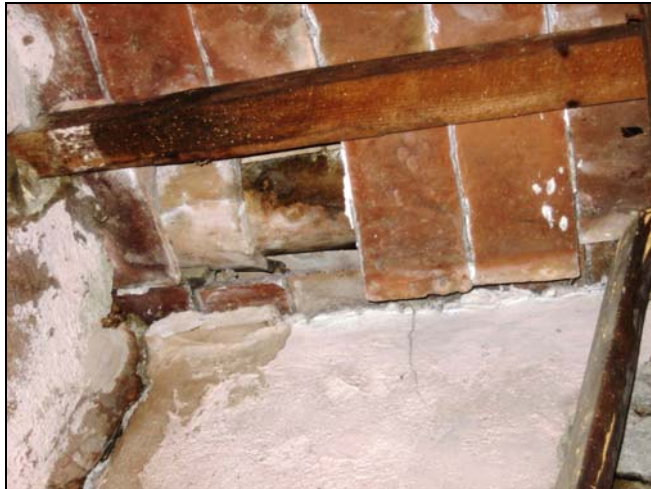
Caiguda de rajoles a la coberta.
