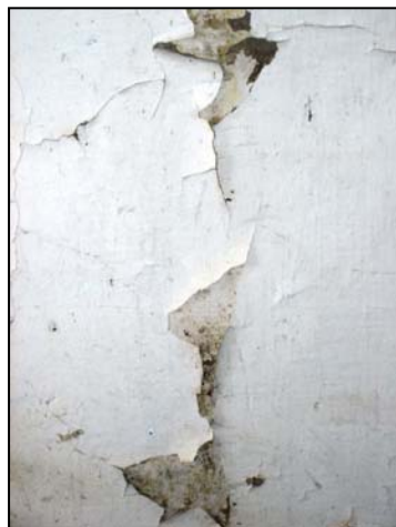
Despreniment de pintura.
