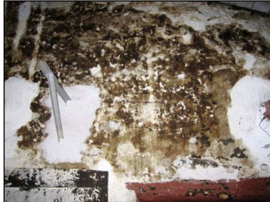
Mur interior afectat per les humitats.
