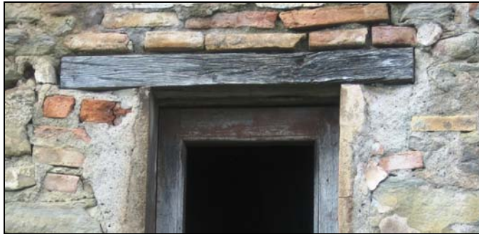
La fusteria exterior tampoc exempta de deteriorament.
