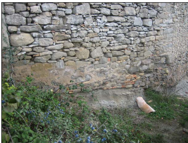
Inici dels murs
