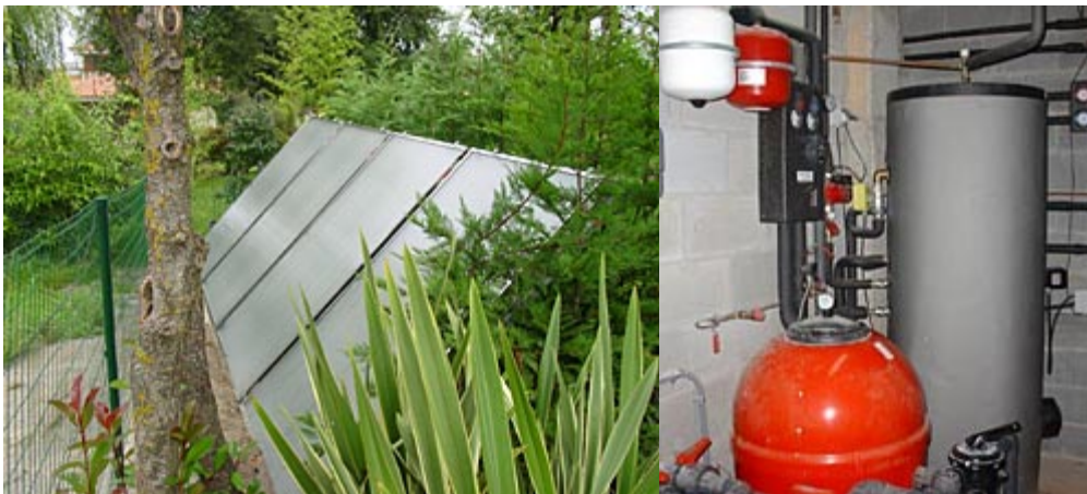
Esquema Instal·lació solar per a aigua calenta sanitària i calefacció
