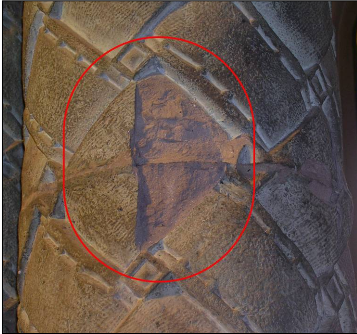
FIG 18: A dalt a l'esquerra, escamació del revestiment del pilar. Localització 16 en el plànol.
