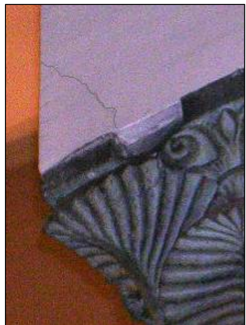
FIG 25: A l'esquerra es mostra la fisura al peu del pilar.
