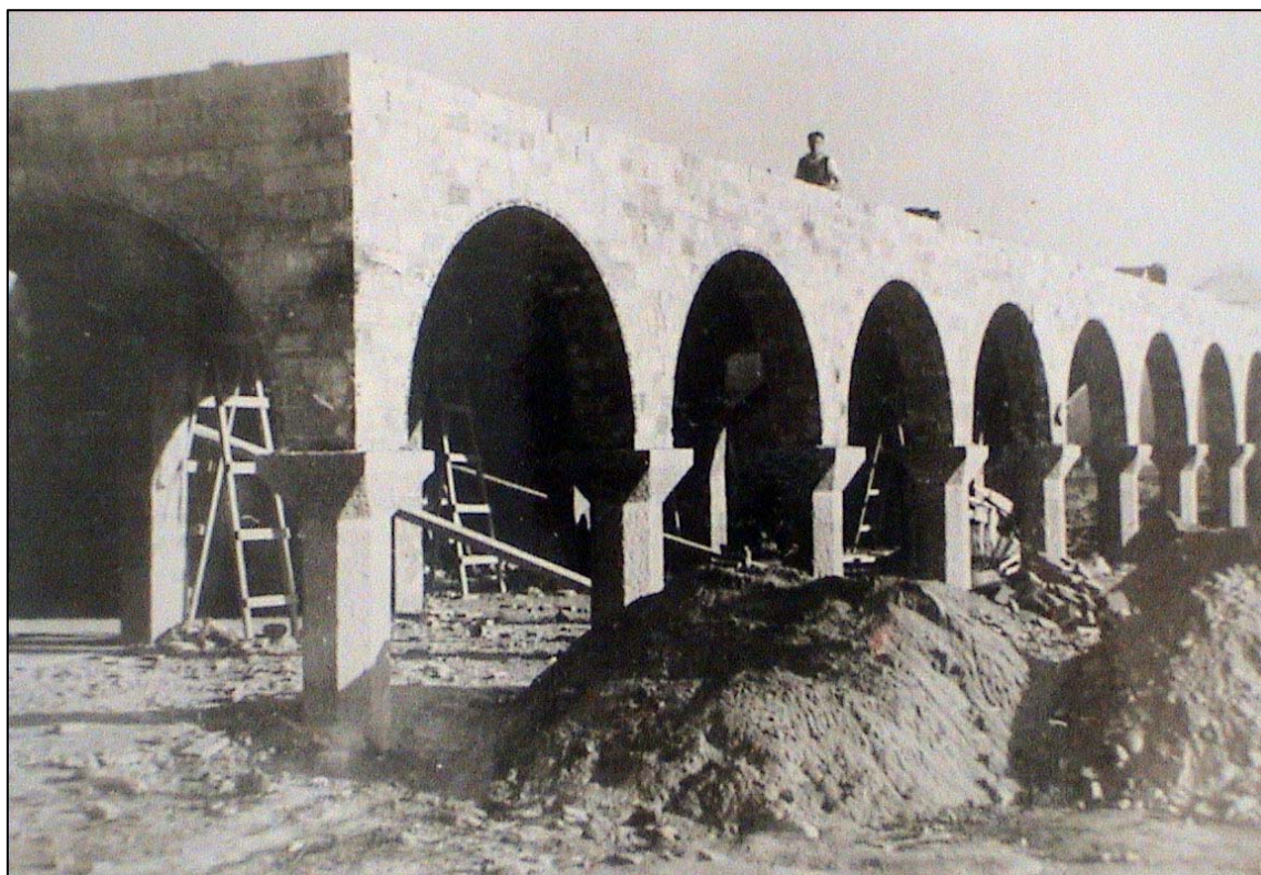
FIG 2: Plaça de l'Assumpció en plena construcció, finals dels anys 40. S'observen els pilars de pedra que conformen la base sobre la qual es recolzen els arcs i les voltes dels porxos. Font: Arxiu municipal de Girona
