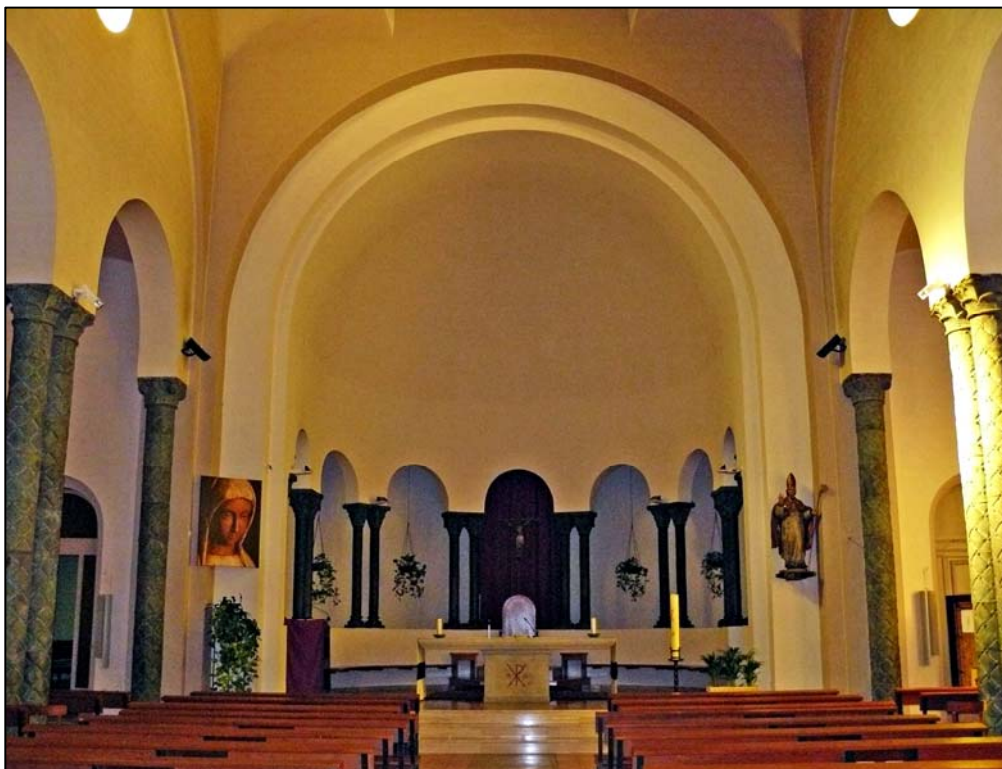
FIG 3: La fotografia de dalt mostra l'església vista des de sota la nau principal cap a l'absis, aquest situat al fons de la imatge. En els laterals s'hi situen els diferents arcs que posteriorment es descriuran, a més dels pilars ceràmics o els de pedra artificial.
