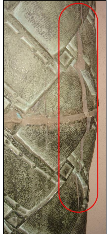
FIG 18: A dalt a l'esquerra, escamació del revestiment del pilar. Localització 16 en el plànol.
