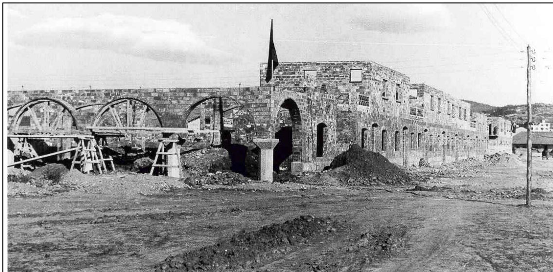
FIG 1: Plaça de l'Assumpció en plena construcció. S'observa que encara mancava la urbanització dels carrers alhora que es comprova la precarietat dels mitjans auxiliars utilitzats en la realització de l'obra. Finals dels anys 40. Font: Arxiu municipal de Girona
