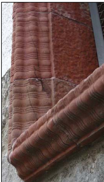
FIG 15: Esquerdes en el marc que limita l'obertura. Localització 21 en els plànols
