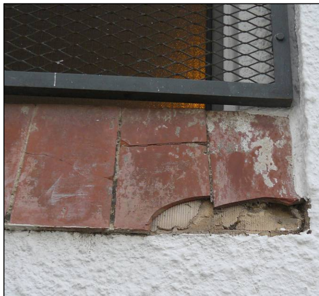
FIG 15: Esquerdes en el marc que limita l'obertura. Localització 21 en els plànols
