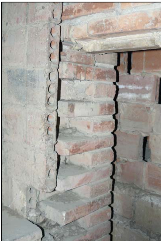
FIG 8: La foto de dalt a la dreta està presa des de l'interior del campanar, en un petit forat que connecta amb la coberta però a la qual no s'hi pot accedir ja que queda "tapiada" pels envanets de sostre mort, que s'aprecien al fons de la foto. Tanmateix, en primer terme es poden veure les diferents fulles que componen el tancament del campanar, que s'han descrit anteriorment. Font: Fotografia pròpia.
