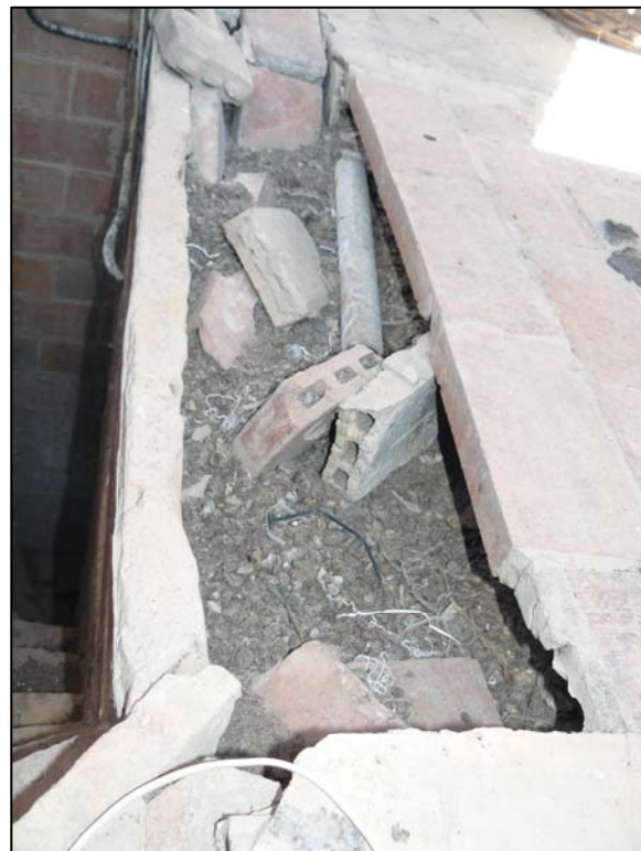
FIG 8: La foto de dalt a la dreta està presa des de l'interior del campanar, en un petit forat que connecta amb la coberta però a la qual no s'hi pot accedir ja que queda "tapiada" pels envanets de sostre mort, que s'aprecien al fons de la foto. Tanmateix, en primer terme es poden veure les diferents fulles que componen el tancament del campanar, que s'han descrit anteriorment. Font: Fotografia pròpia.
