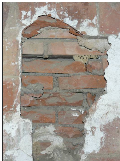
FIG 13: A l'esquerra, trencament de peces que conformen la fulla interior de la paret de tancament del campanar.
