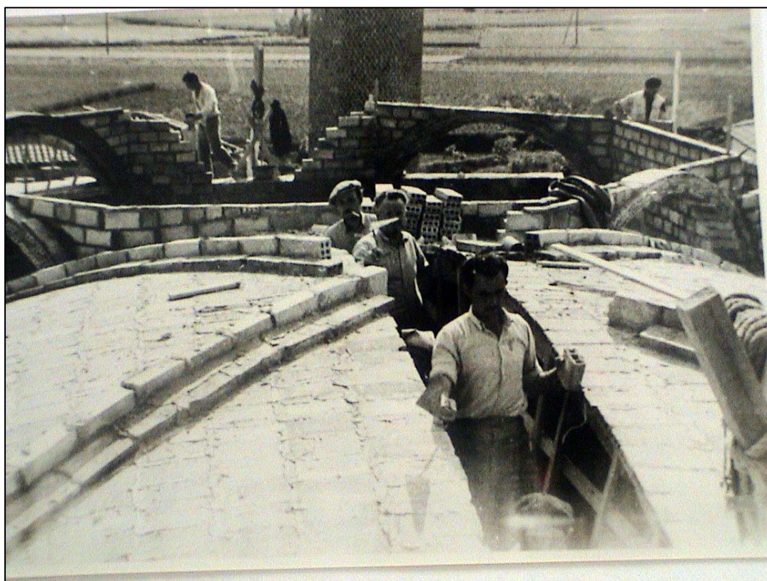
FIG 8: En la fotografia de dalt es pot observar uns obrers finalitzant la construcció d'una volta de quatre punts amb tan sols una filada de maó foradat col·locat en pla, de dimensions força grans i amb quatre costelles en cadascuna de les diagonals.
