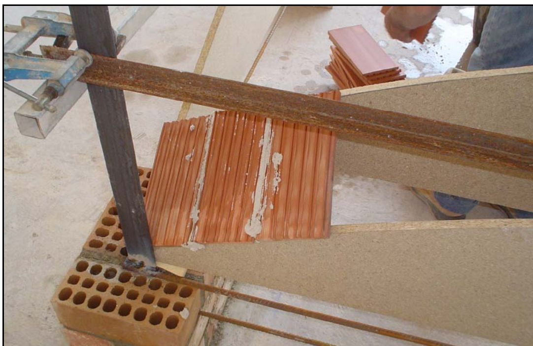
FIG 7: En la fotografia es pot observar la col·locació dels cindris d'una volta de quatre punts amb arc generador de curvatura variable (per tant, el cindri es desplaçarà seguint la curvatura dels altres dos cindris laterals). La foto correspon a la construcció que féu Arnau Blancafort en el seu PFC. En aquesta, a part d'utilitzar una curvatura substancialment diferent, també aplicà altres materials com és la rasilla ceràmica.
