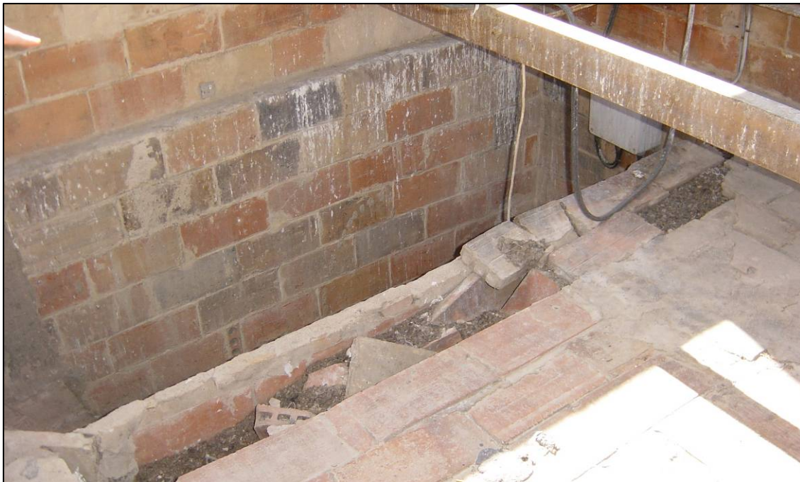
FIG 14: Trencament del paviment que conforma la capa d'acabat de l'últim nivell del campanar.
