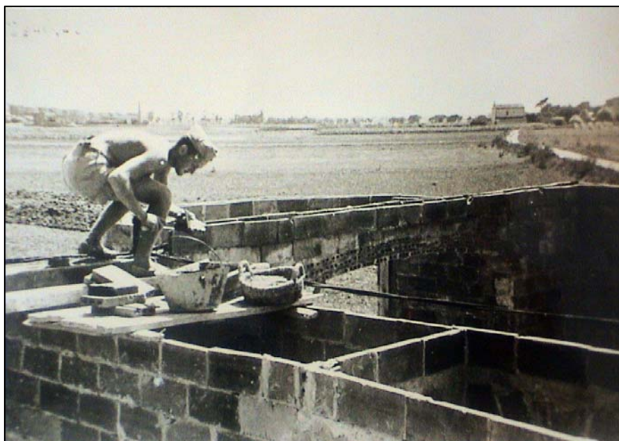
FIG 10: En la fotografia de l'esquerra s'observa un obrer executant un ar. Alhora, s'hi poden apreciar els cables de ferro que treballaran com a tirants.
