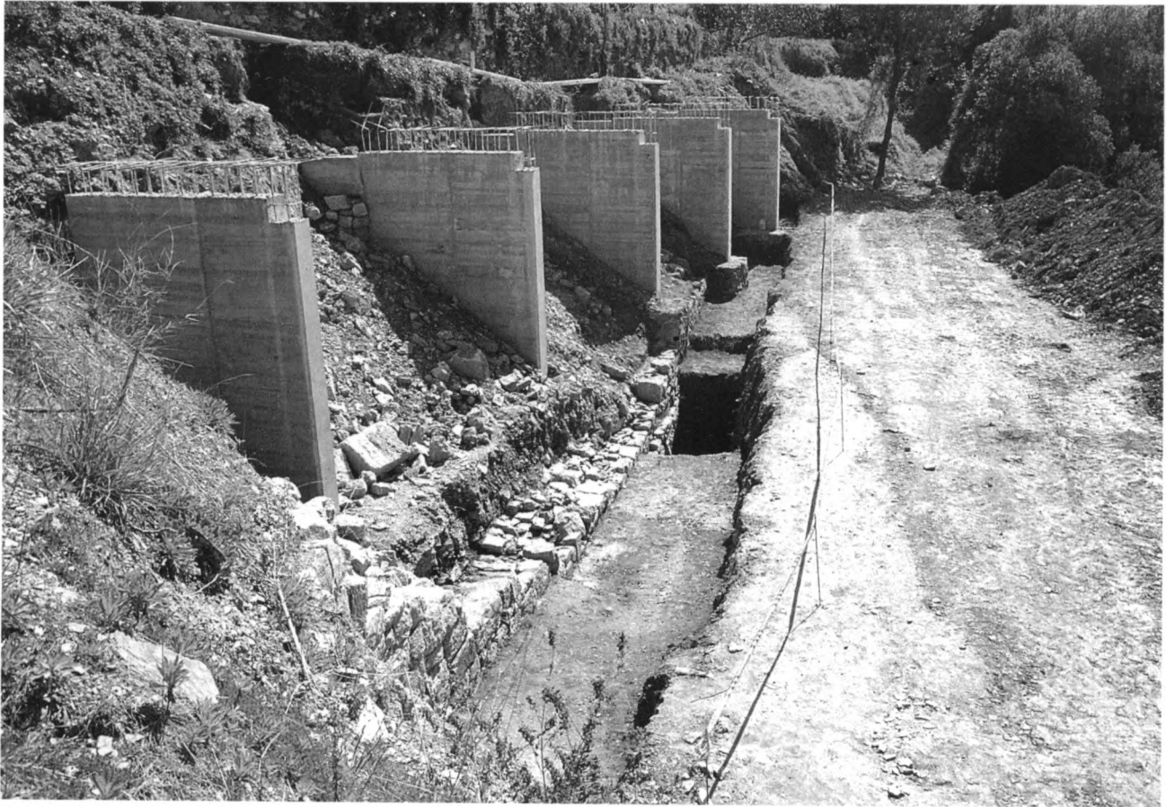
Fig. 3.- Fotografia de la zona excavada, situada a ponent de l'església dels Sants Metges
