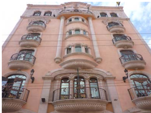
Fig. 4. Una tipología arquitectónica característica de los hoteles y de otras construcciones de San Juan de los Lagos, es una modalidad neobarroca, que utiliza molduras, nichos, marcos, remates y columnas de cantera además de herrerías exóticas
