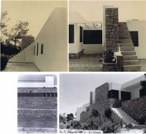
Fig. 4. E. Donato, Casa Mangrané, vistas y detalles
