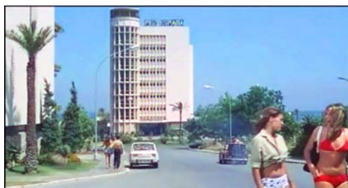
Fig. 3. Hotel Pez Espada, Torremolinos. Fotograma de la película Cuidado con las señoras, 1968.
