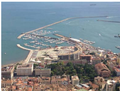
Veduta aerea del cantiere di Piazza della Libertà (settembre 2013): il Crescent in costruzione e sullo sfondo la stazione marittima.
