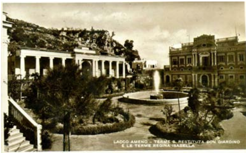
2. La piazza del Municipio di Lacco Ameno prima dei progetti di Rizzoli: a sinistra le Terme Regina Isabella e a destra le Terme Santa Restituta, dove sorgerà l'albergo Regina Isabella.
