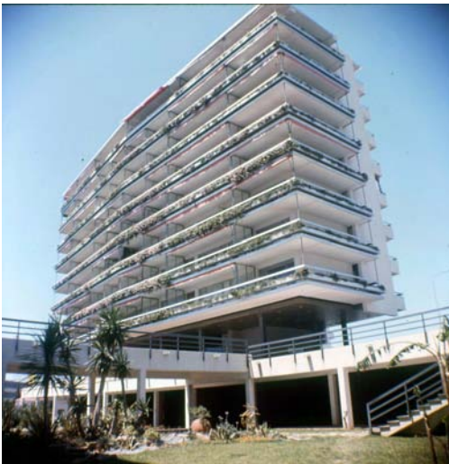
Fig. 3: Edificio de Apartamentos Eurosol, Torremolinos. Rafael de La Hoz y Gerardo Olivares. 1963
