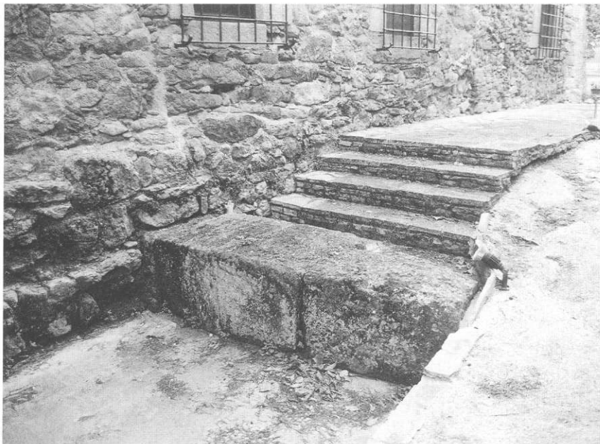
Fig. 33. Mur perimetral d' opus quadratum de la vil·la del Mas de Dalt.
