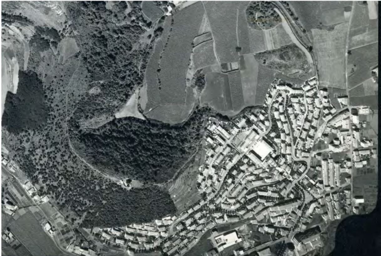
IMATGE 6: GRUP D'HABITATGES DE SANT PERE MÀRTIR. ANY 1969.
