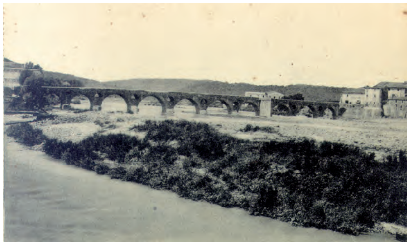
Fig.4. Pont sobre el Ter a Sarrià. Destruït durant la guerra civil conservava elements del pont romà original.
