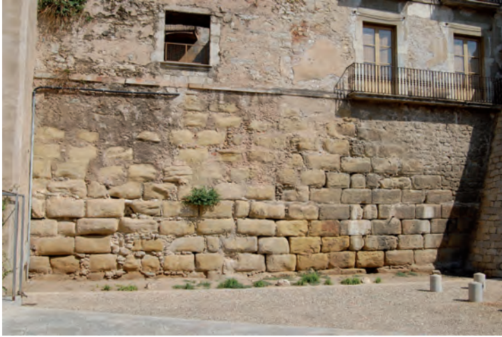
Fig.36. Tram de la muralla tetràrquica a la zona de la plaça sant Domènec-portal Rufí.
