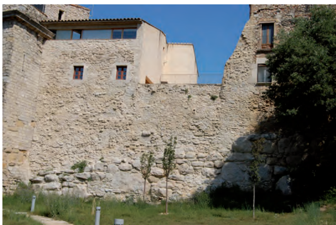
Fig.38. Sector de migdia de les muralles. A la part inferior d'un parament d'època medieval, es conserva un tram de les muralles republicanes bastides amb grans blocs irregulars,
