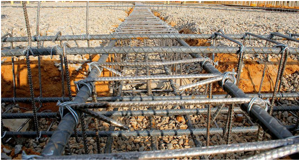
Figura 5. Barres de reforç d'acer
