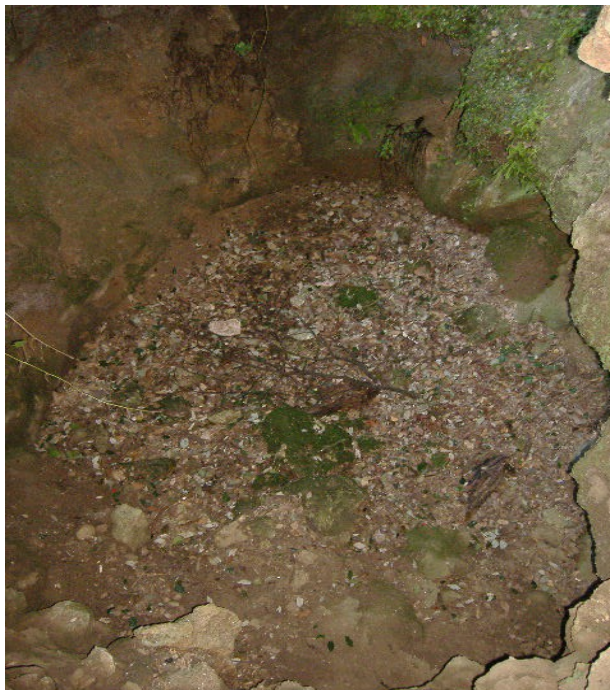
Fig. 69: Cala de Davant Pau, reomplert amb sediment caigut de la secció amb Pau-V (Fotografia: Isaac Rufí, 12-II-2012).
