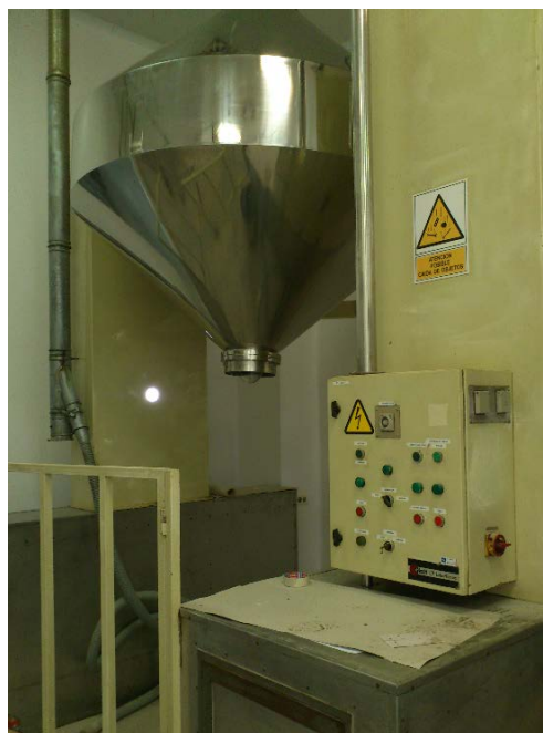
Figura 2 Estat actual de la instal·lació, amb els suports inferiors instal·lats.
