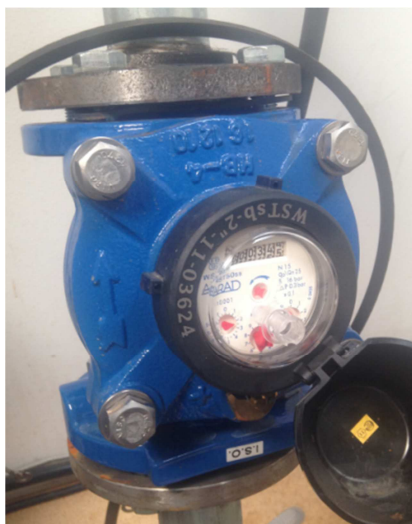
Figura 28. Comptador volumètric per mesurar el cabal en un temps determinat
