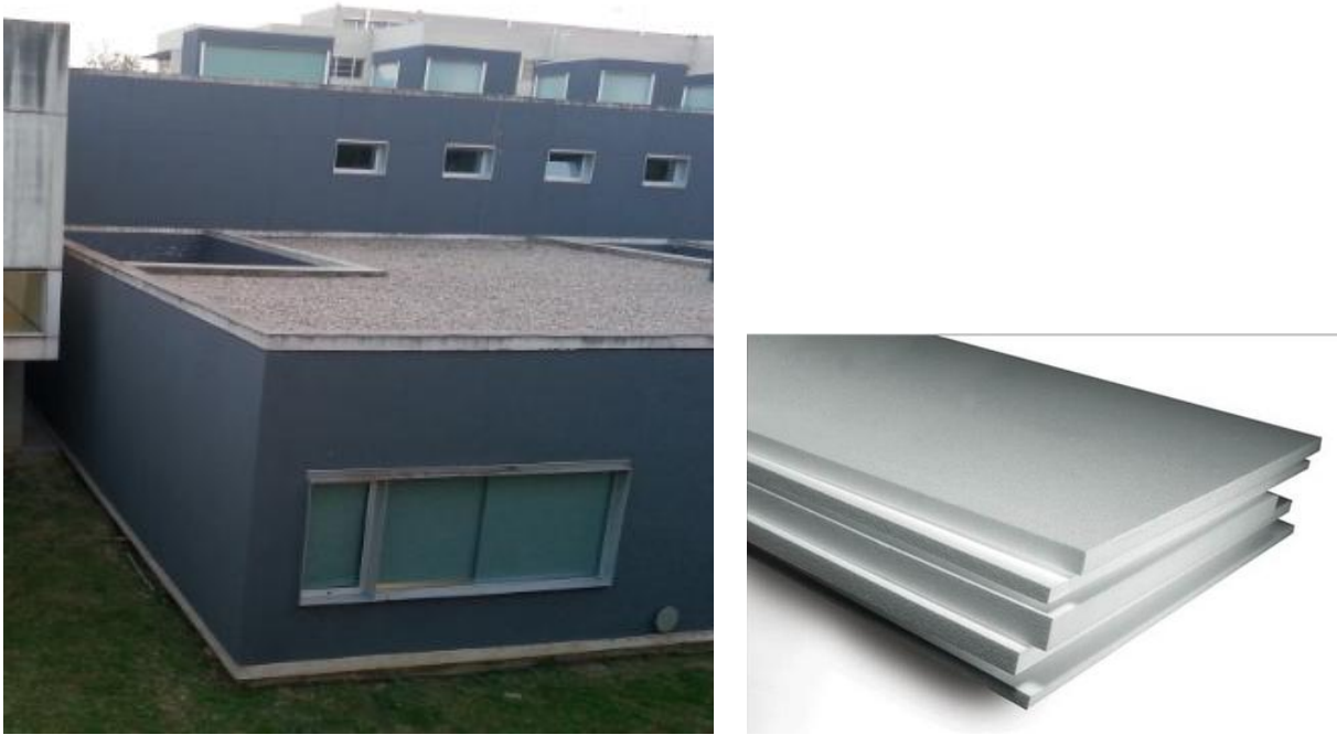
Fotografia 33 : Coberta plana invertida acabada en grava de l'edifici.
