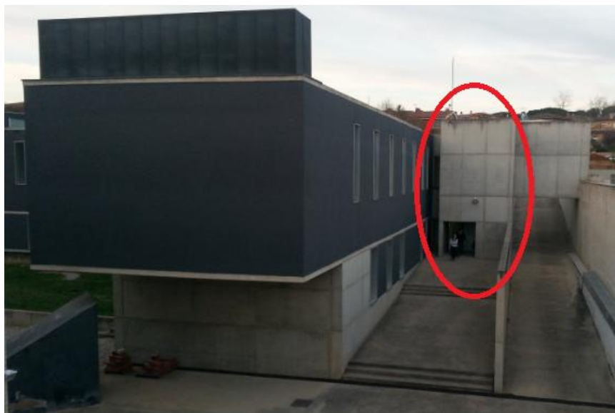
Fotografia 25: Vista de la caixa d'escala zona est des de l'exterior
