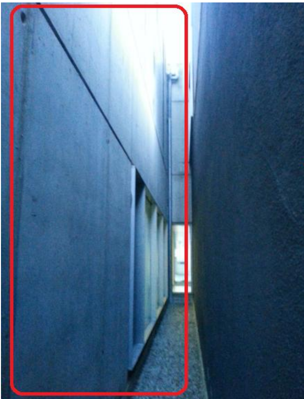
Fotografia 28: Vista de la caixa d'escala zona est des de l'exterior
