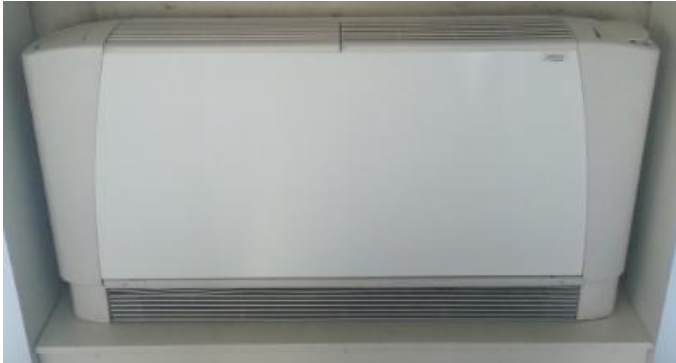
Fotografia 16: Fancoil marca “Roca” model RFT
