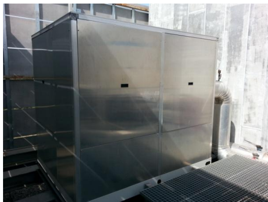
Fotografia 15: Grup hidràulic marca “Climaveneta” model SP-24-807-2500
