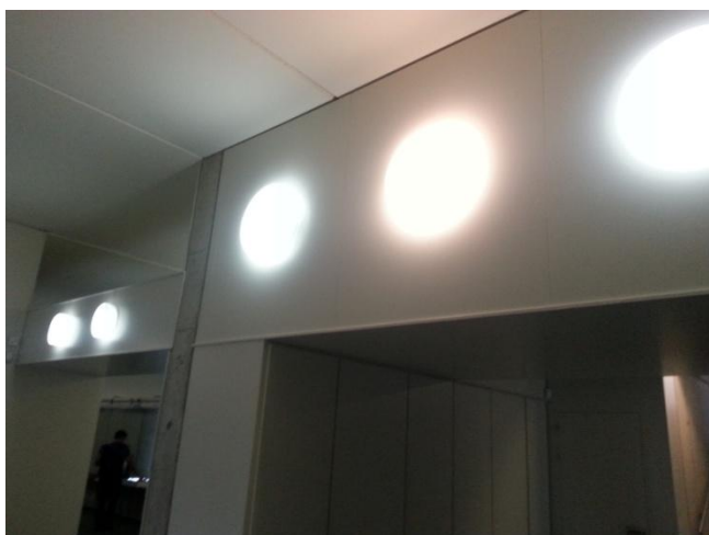
Fotografia 44: Sistema d'il·luminació actual dels passadissos amb difusors cilíndrics
