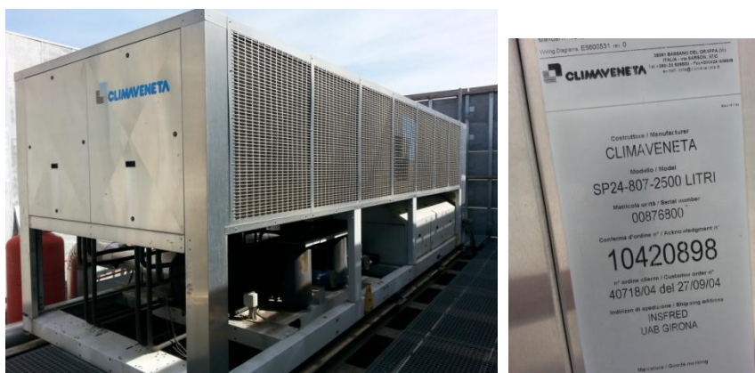
Fotografia 14: Planta climatitzadora marca “Climaveneta” model SRAN2004/SL
