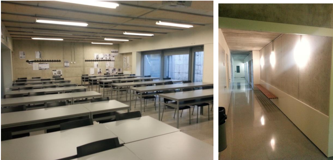
Conjunt fotogràfic 17: Sistema d'il·luminació interior del centre
