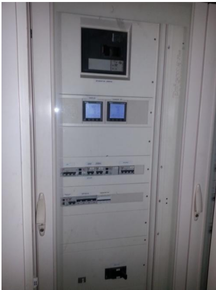
Conjunt fotogràfic 22: Analitzador de xarxes "Schneider Electric series PM700" de PowerLogic
