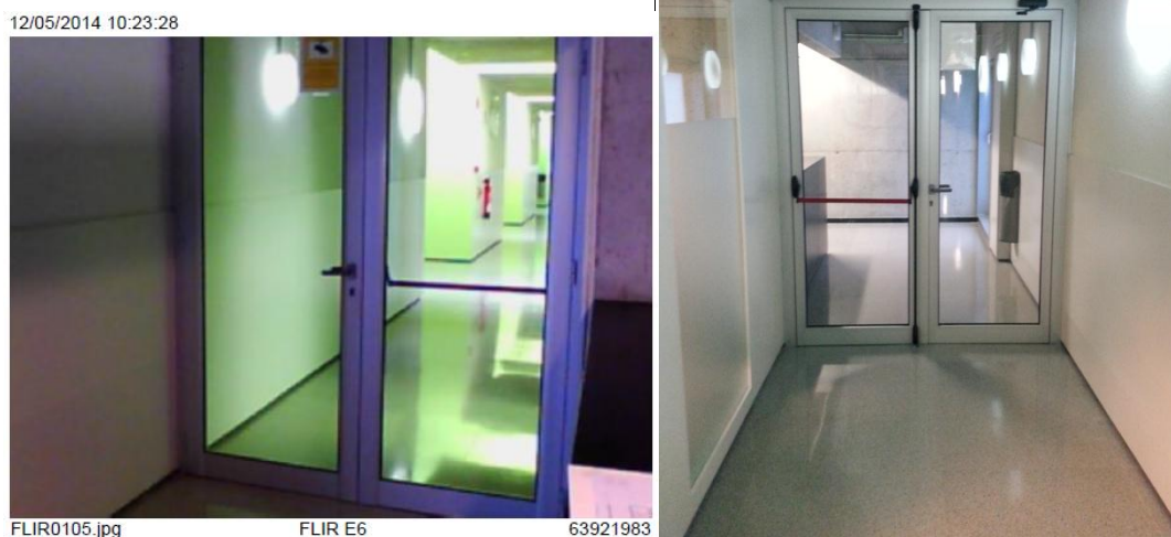
Conjunt fotogràfic 39: Portes de sectorització del passadís de Planta Pis
