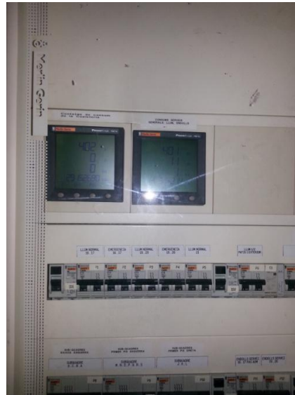
Conjunt fotogràfic 22: Analitzador de xarxes "Schneider Electric series PM700" de PowerLogic
