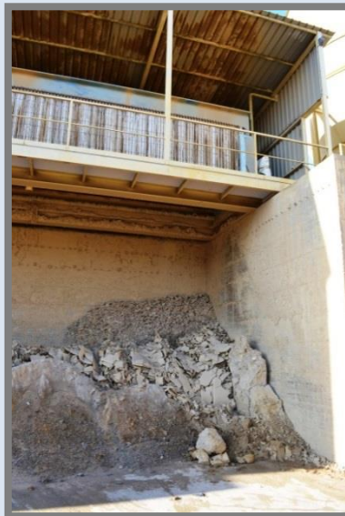
Filtre premsa amb les "galletes" o capes de fang sec.
