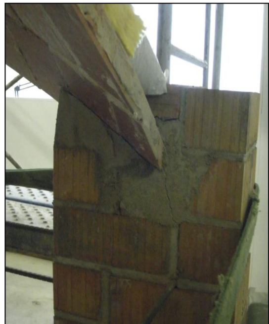
Esquerda en el material d'aferratge i rajols en un dels recolzament .
