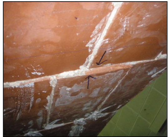
Canvi de nivell de dovelles, pròxim al punt 9.
