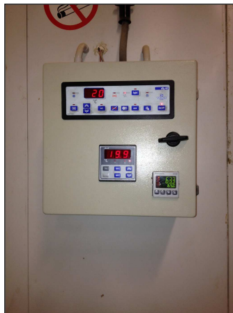
Imatge 39: Emmagatzematge de provetes en la càmera deshumidificadora.
