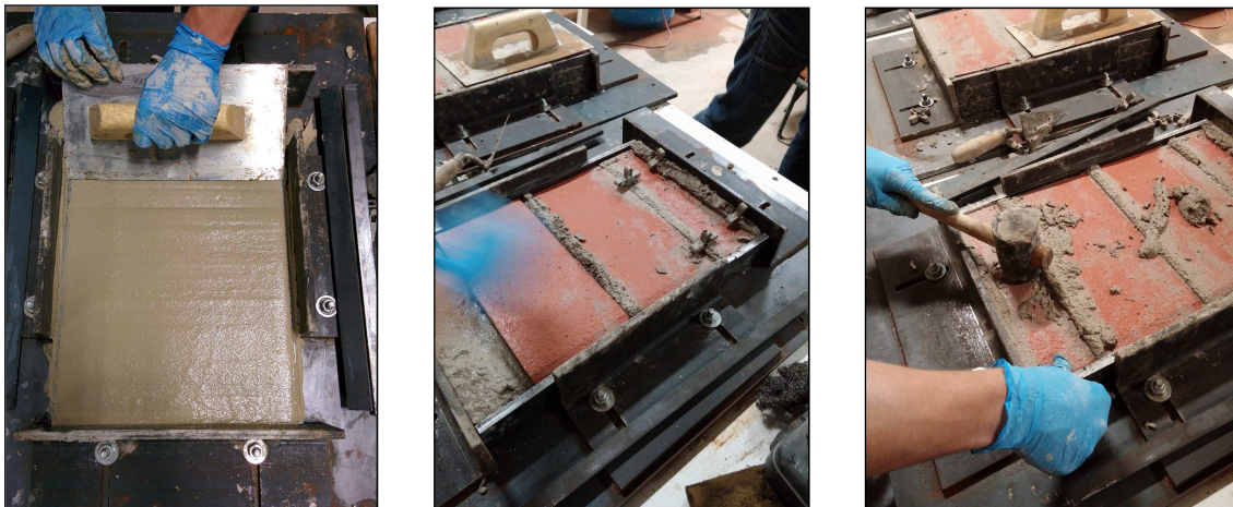
Imatge 28: Col·locació de la tercera peça ceràmica, rejuntar i execució de capa de morter d'1cm.
