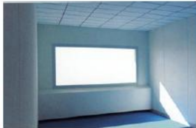
La ventana con voladizo es suficiente en posiciones centrales del sol, pero en posiciones más bajas permite aún demasiado contraste
