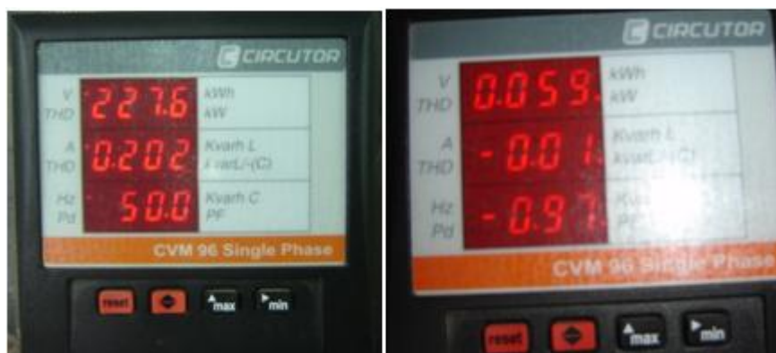
Figures 20 i 21: a l'esquerra, mesura de voltatge i intensitat; a la dreta, mesura de la potència instantània consumida i del factor de potència.
