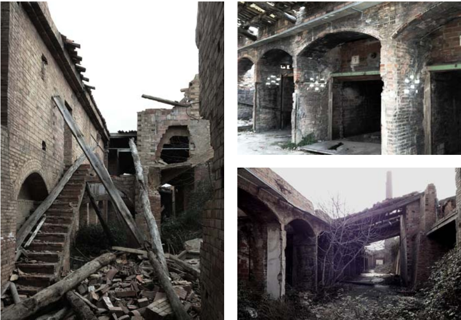
Imatges: escala d'accés a la planta primera (esquerra) / portes d'accés als secadors de rajol (dalt-dreta) / corredor amb xemeneia de fons (dreta-baix)
