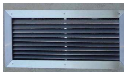
Fig. 11, reixeta de ventilació d'alumini
