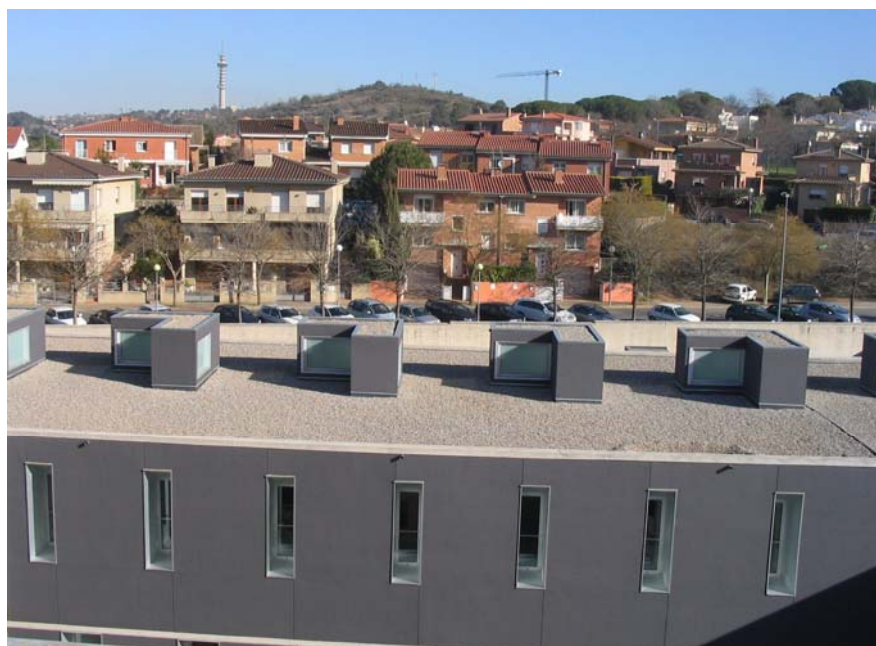
Figura 5. Vista de la coberta de l'edifici Politècnic-3. Ala Sud
