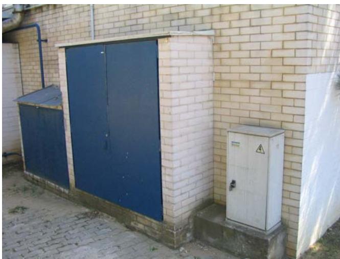
Figura 59. Nínxol per la col·locació de l'equip de protecció i comptatge
