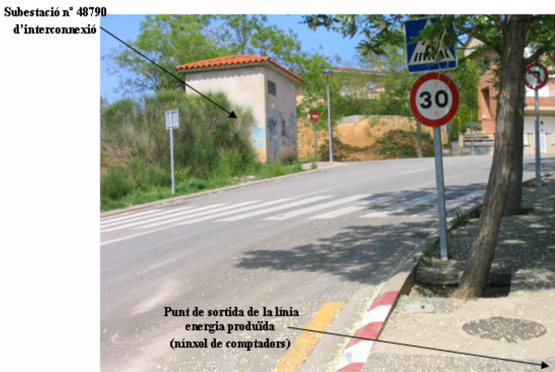
Figura 63. Terrenys per on haurà de discórrer la línia d'evacuació de l'energia produïda
