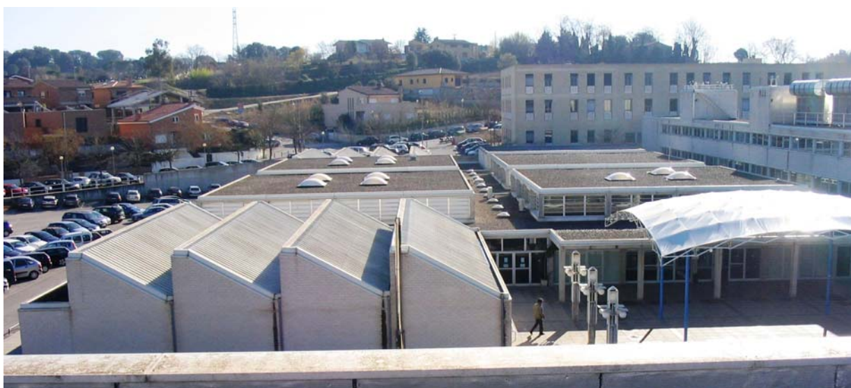
Figura 3. Vista de la coberta de l'edifici Politècnic-2
