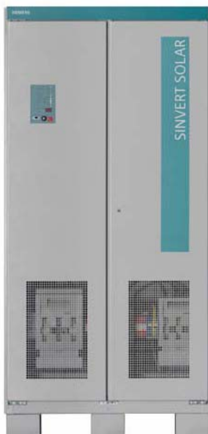
Figura 32. Vista frontal d'un ondulador central Siemens Sinvert de 60 kVA
