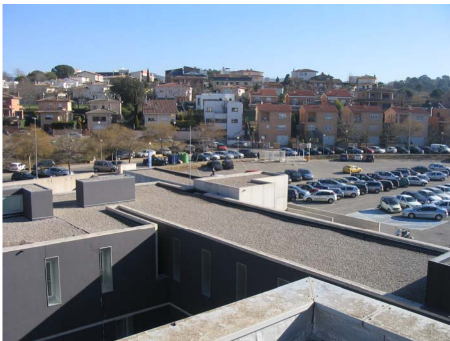
Figura 4. Vista de la coberta de l'edifici Politècnic-3. Ala est
