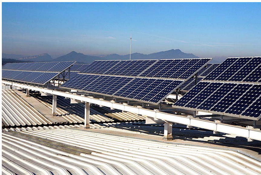
Figura 7. Instal·lació fotovoltaica sobre teulada
