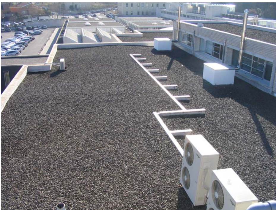
Figura 2. Vista de la coberta de l'edifici Politècnic – 1 on anirien col·locats els panells
