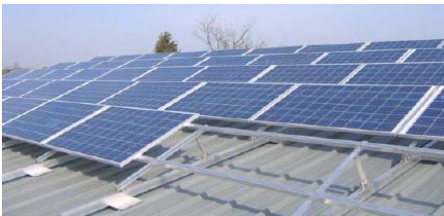
Figura 15. Estructura de fixació sobre coberta
