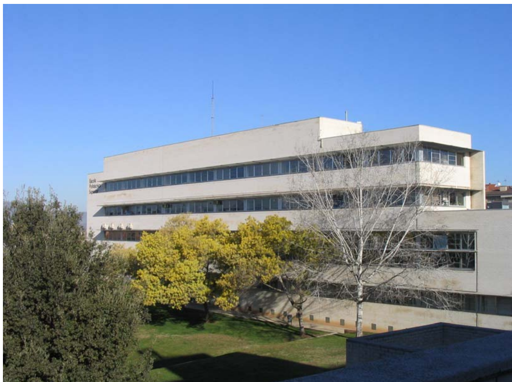
Figura 1. Vista frontal de l'edifici Politècnic – 1.
