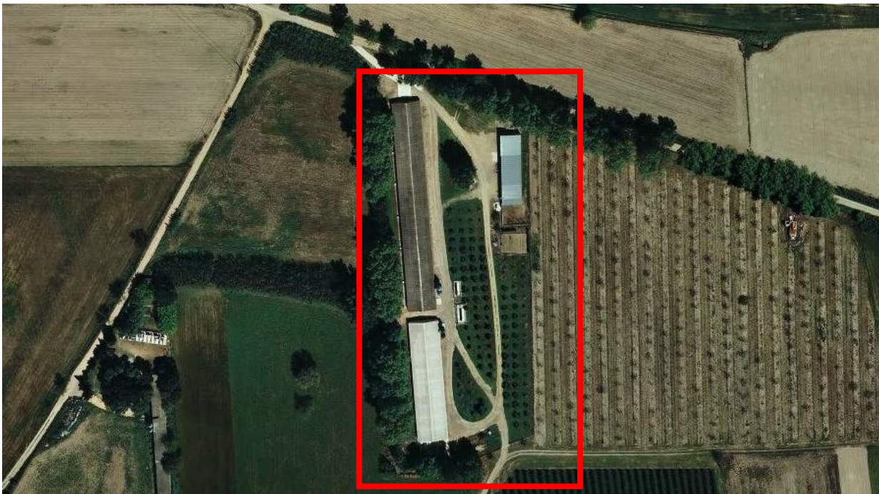
Imatge 01. Fotografia aèria de la situació actual general de la finca
