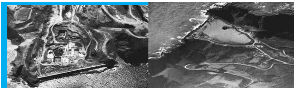
Inici de les obres a la Cala Basordes (1970-1972) Font: http://www.lemoiz.com/
