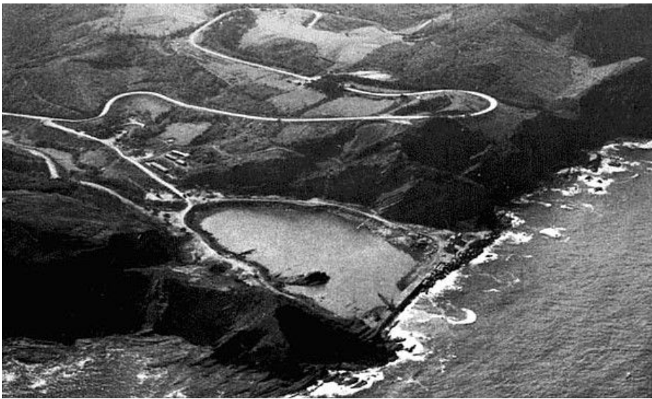
Inici de les obres a la Cala Basordes (1970-1972) Font: http://www.lemoiz.com/
