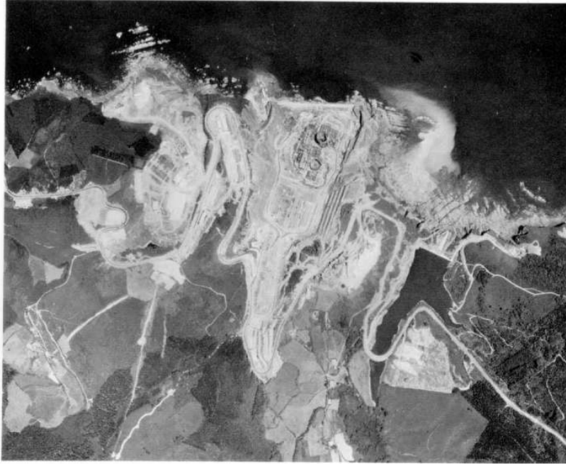
Inici de les obres a la Cala Basordes (1970-1972) Font: http://www.lemoiz.com/
