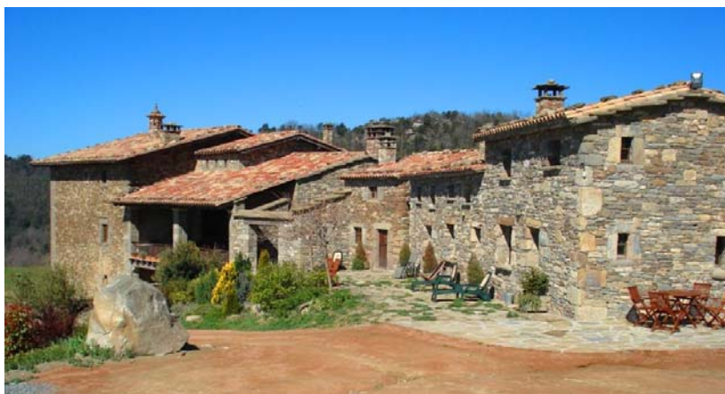
Figura 4 Vista general de "Les Casetes"
