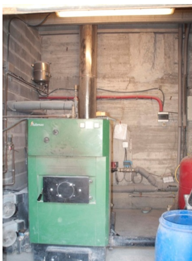
Figura 9 Caldera de biomassa
