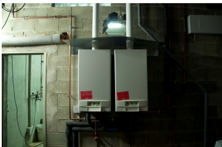
Figura 11 Detall de les calderes estanques
