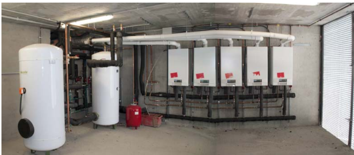
Figura 10 Sala de les calderes atmosfèriques i acumuladors
