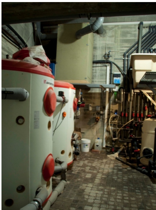
Figura 12 Dipòsit d'Inèrcia 1 i part del circuit primari de la piscina climatitzada
