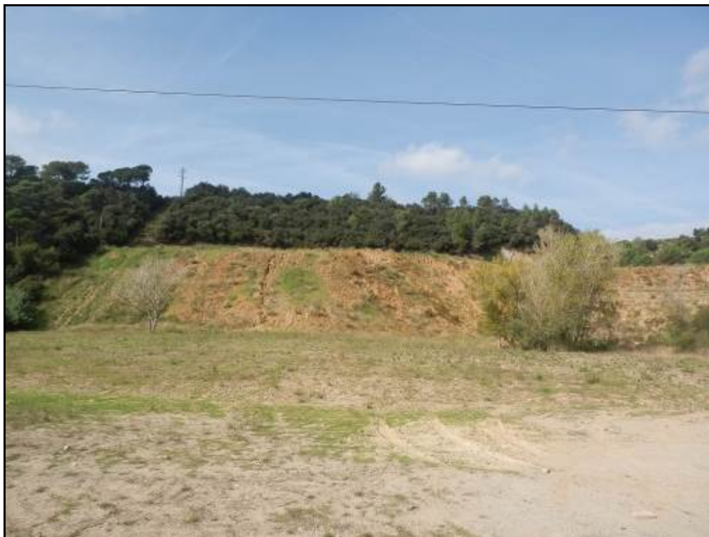
Foto 23. Vista frontal del talús de l'acopi de terres que dóna a l'esplanada de la zona 2. Zona 3
