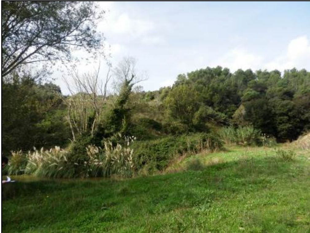
Foto 18. Vista de l'estat actual del talús posterior de la bassa 2. Zona 2
