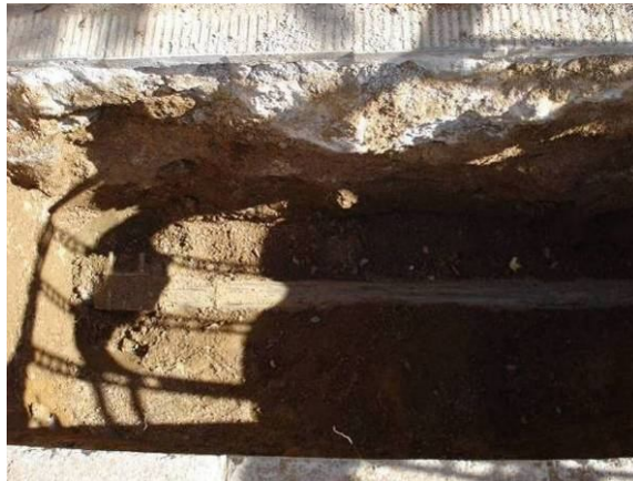
Figura 23. Collarí de reparació sobre la canonada de distribució
