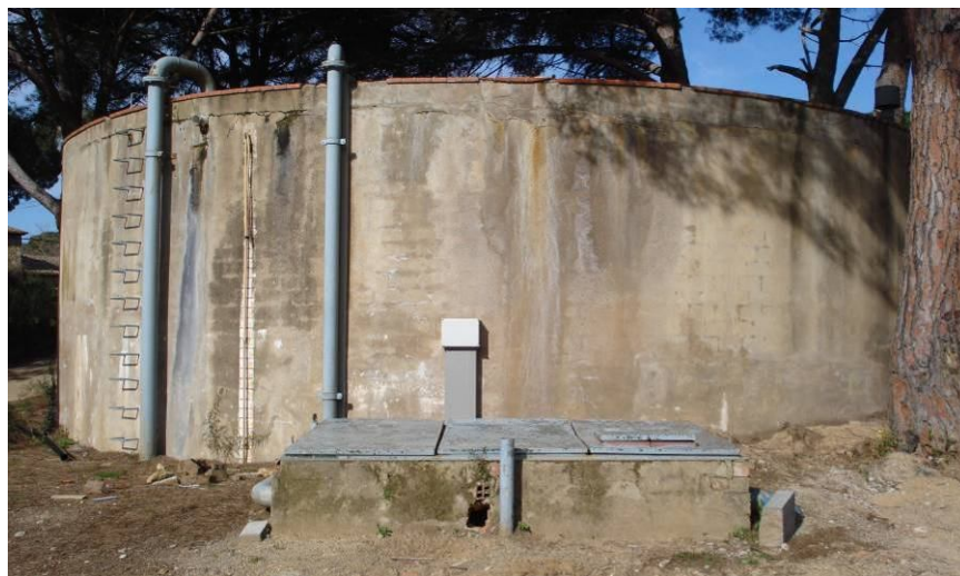
Figura 5. Vista de l'arqueta de bombament del dipòsit Pulmó
