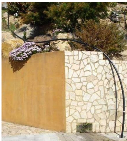
Figura 24. Canonada de subministrament per sobre els murs
