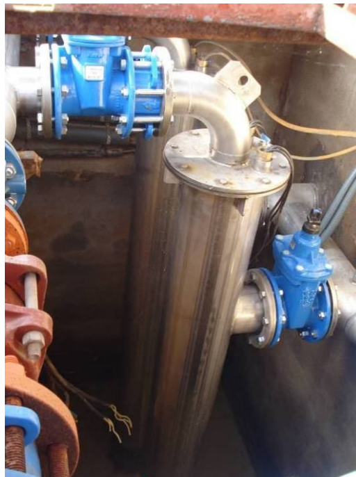
Figura 9. Vista de les campanes d'aspiració
