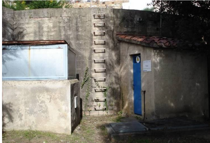
Figura 7. Vista del dipòsit Intermig
