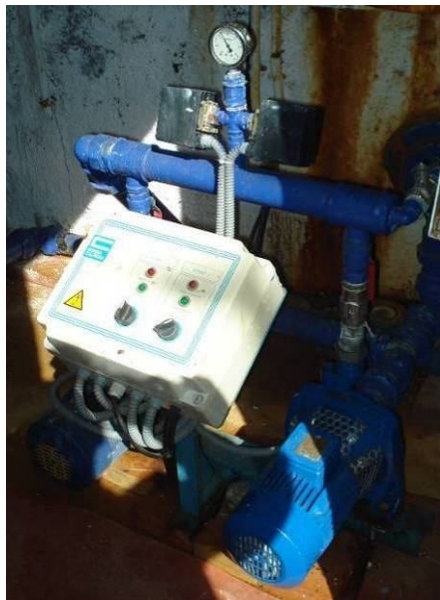
Figura 13. Vista del grup de pressió del Dipòsit Cim
