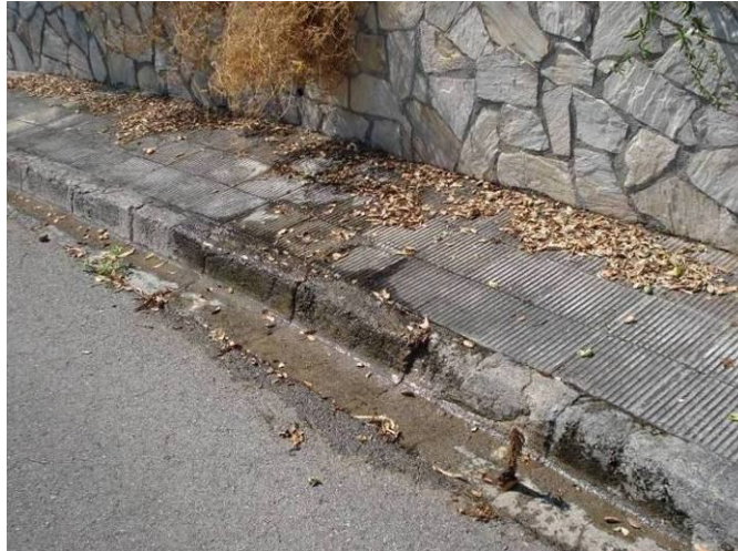
Figura 22. Avaria a la xarxa de la urbanització de Cabanyes
