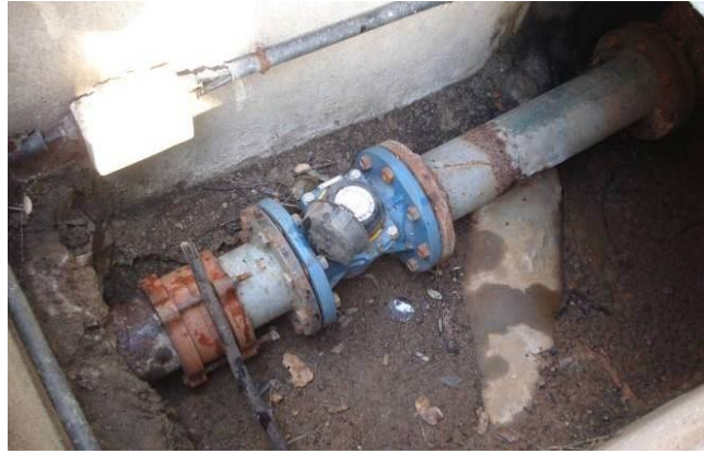
Figura 12. Vista del col·lector i comptador de sortida del Dipòsit Internig
