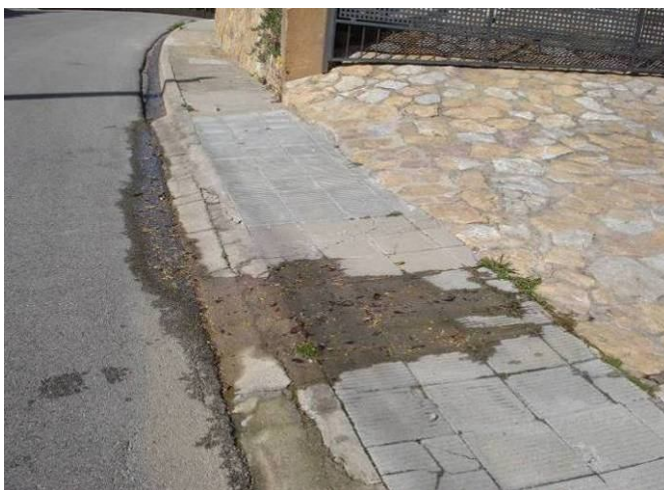
Figura 21. Avaria a la xarxa de la urbanització de Cabanyes
