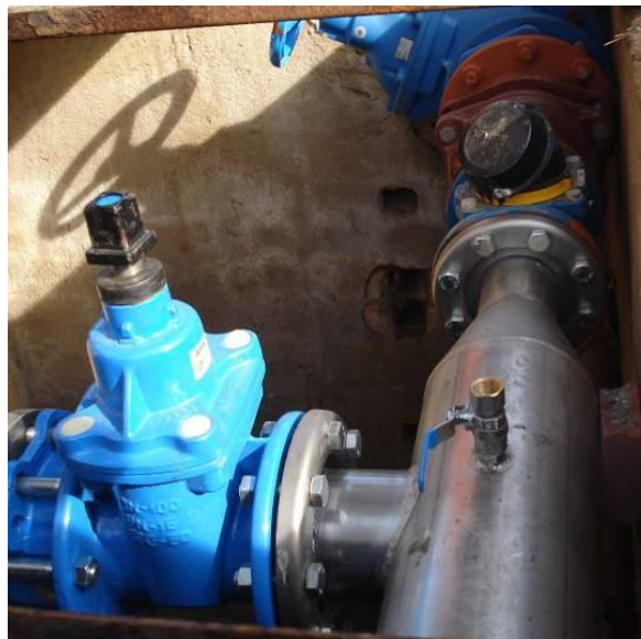
Figura 10. Vista del col·lector i comptador de sortida del Dipòsit Pulmó
