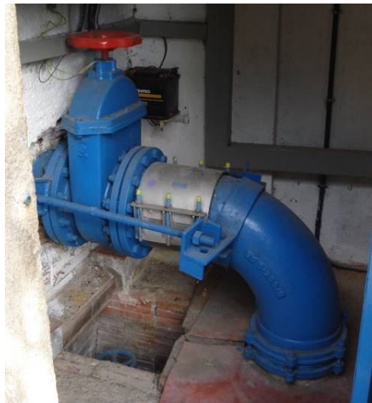
Figura 11. Col·lector d'entrada al dipòsit Intermig
