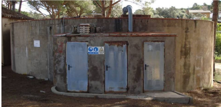
Figura 4. Vista del dipòsit Pulmó
