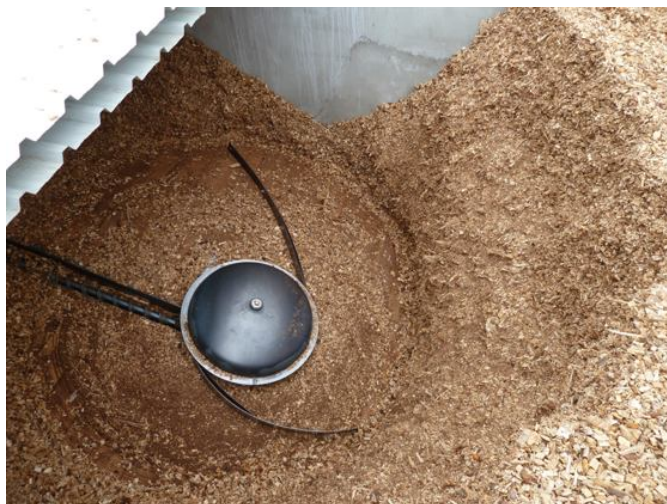
(Fig. 2 Fotografia de sitja amb sistema agitador de ballestes)
