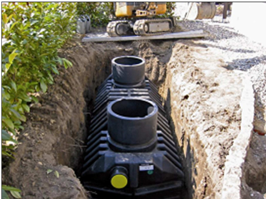
Fig 9.7. Reactor Biològic Seqüencial soterrat.
