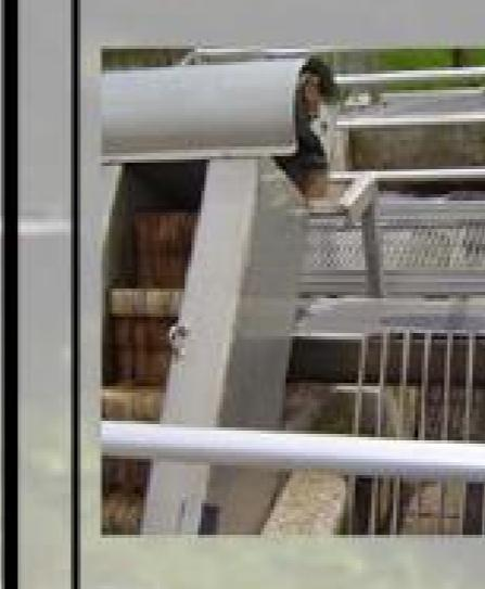
Protegeix l'estació depuradora de residus capaços d'obturar les diferents parts del tractament i separació dels sòlids més voluminosos.
