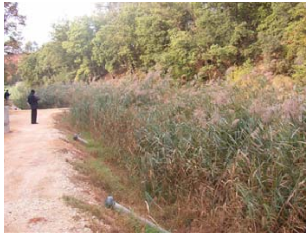
Figura 68: Wetland de flux vertical del Roussillon (França).
