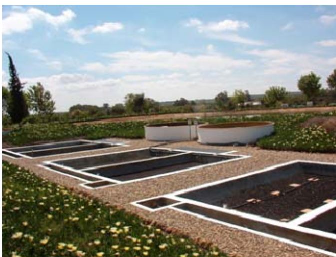
Figura 41: Llits de torba de la planta experimental de Carrión de los Céspedes (Sevilla).
