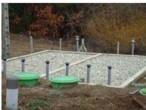
Figura 42: Exemple de llits filtrants.
