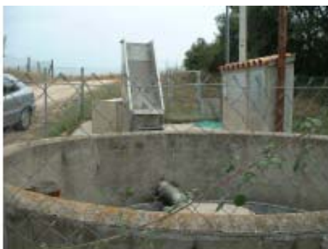
Figura 31: Exemple de decantador primari circular.
