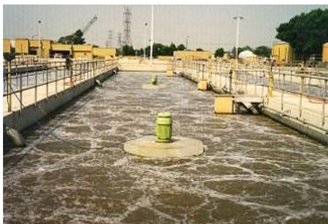
Figura 32: Reactor Discontinu Seqüencial en fase de reacció.
