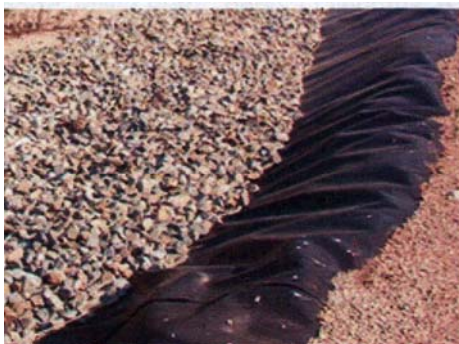
Figura 61 : Fotografia de la capa impermeabilitzant.
