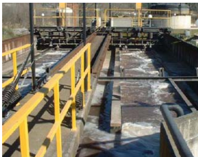
Figura 27: Dessorrador-desgreixador en funcionament.
