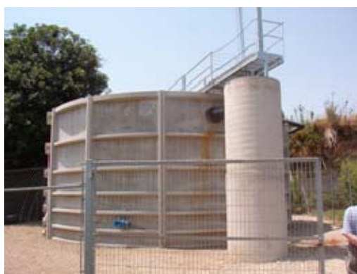
Figura 30: Vista lateral d'un Tanc Imhoff.
