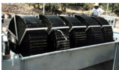
Figura 33: Sistema de biodiscs en funcionament
