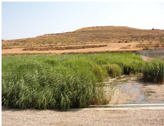
Figura 69: SAC subsuperficials de flux horitzontal.
