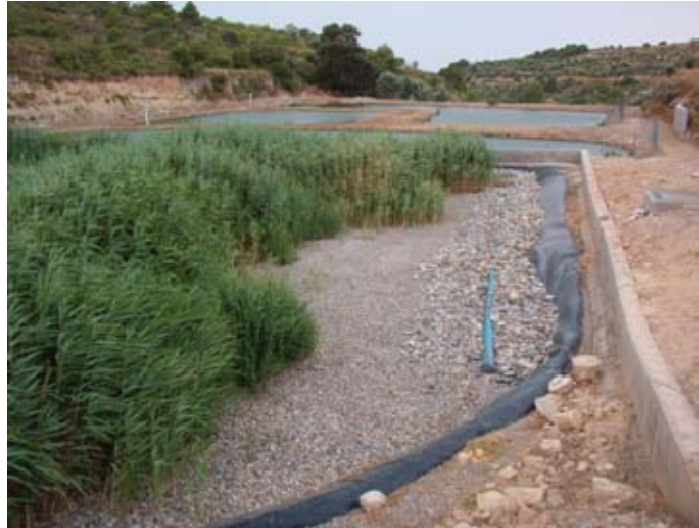
Figura 43: EDAR d'Almatret on podem veure el SAC com a tractament secundari i al fons un llacunatge com a tractament terciari.
