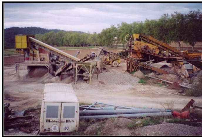
Foto 3: La planta de tractament d'àrids abans de l'última reforma
