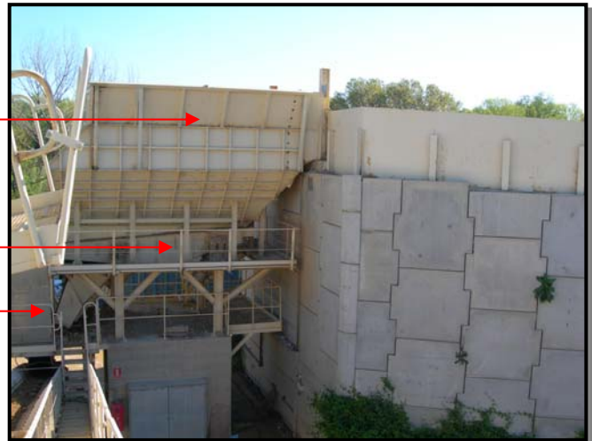
Foto 9: tolva, alimentador, matxacadora
