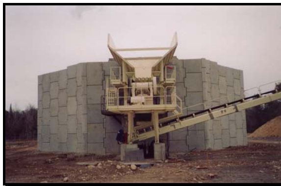
Foto 8: la rampa amb la tolva de recepció de material
