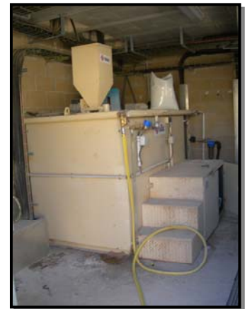
Foto 37: tanc de flocculació
