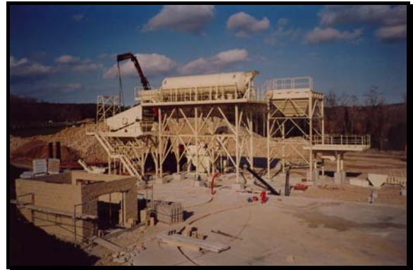
Foto 5: construcció de la caseta de comandaments i tròmel
