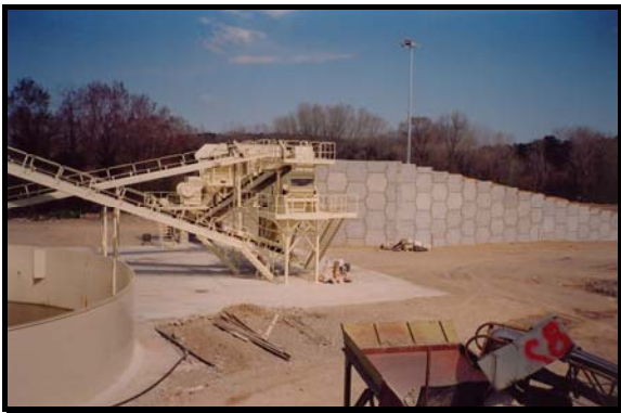
Foto 6: construcció de la rampa per abocar el material
