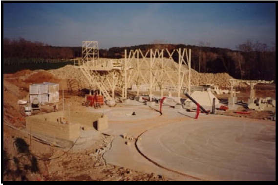
Foto 4: construcció plataforma formigó
