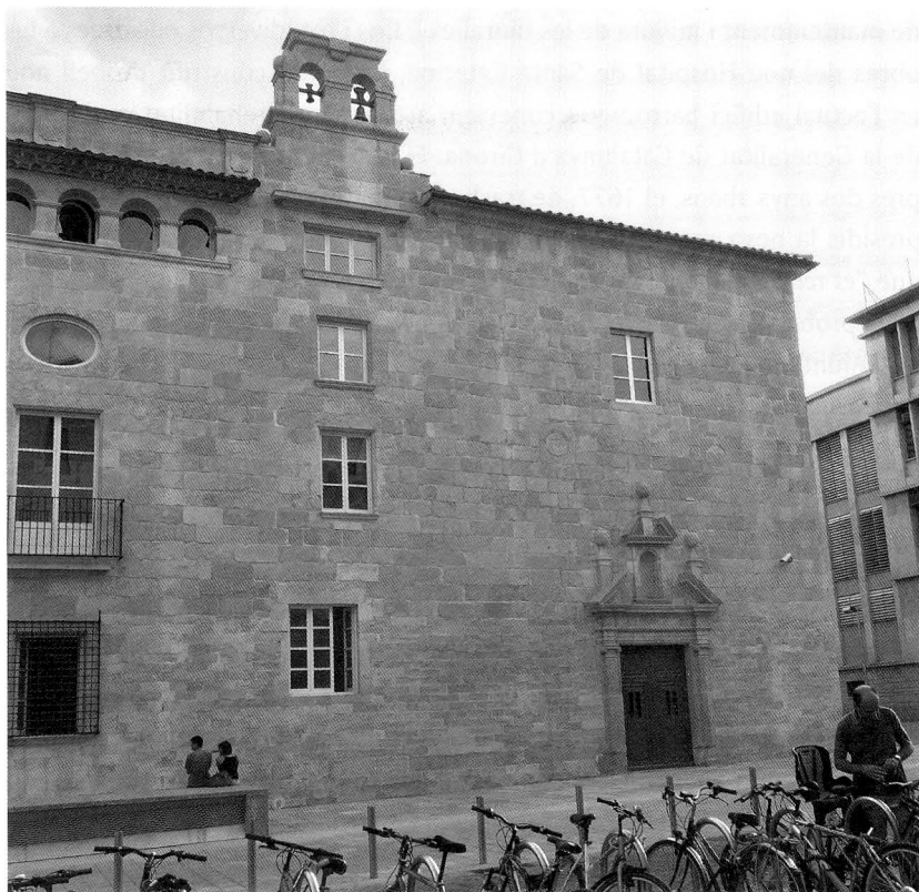
Fig. 6. Detall de la façana de l'antiga capella de l'Hospital Santa Caterina de Girona. Fotografia: Isabel Juan.
