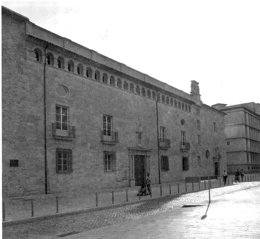
Fig. 1. Façana de l'antic Hospital de Santa Caterina, avui edifici de la Generalitat a Girona. Fotografia: Isabel Juan.
