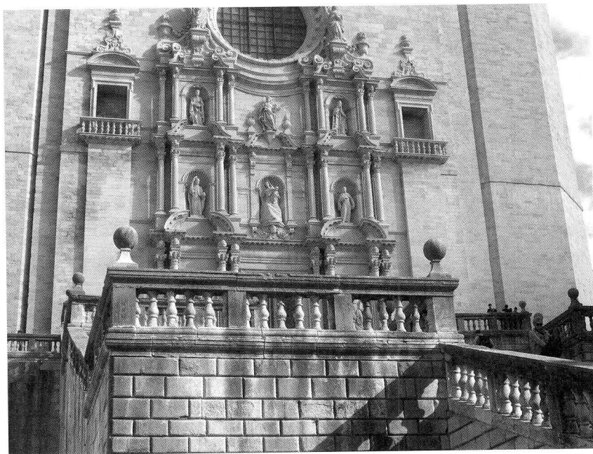
Figura 8. Segona i tercera andana de la façana de la catedral de Girona, amb el primer replà de l'escala que li dóna accés en primer terme. Fotografia de l'autor.
