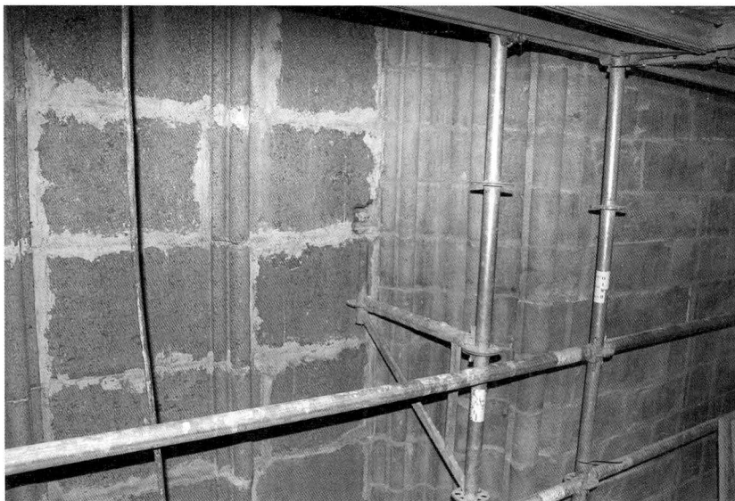
Fig. 3. Detall del paredat en pedra del finestral nord-oest. Foto: Gustavo Torres.
