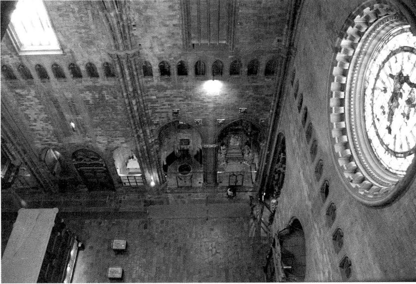
Fig. 1. Façana interior sud del tercer i quart tram de la nau.
