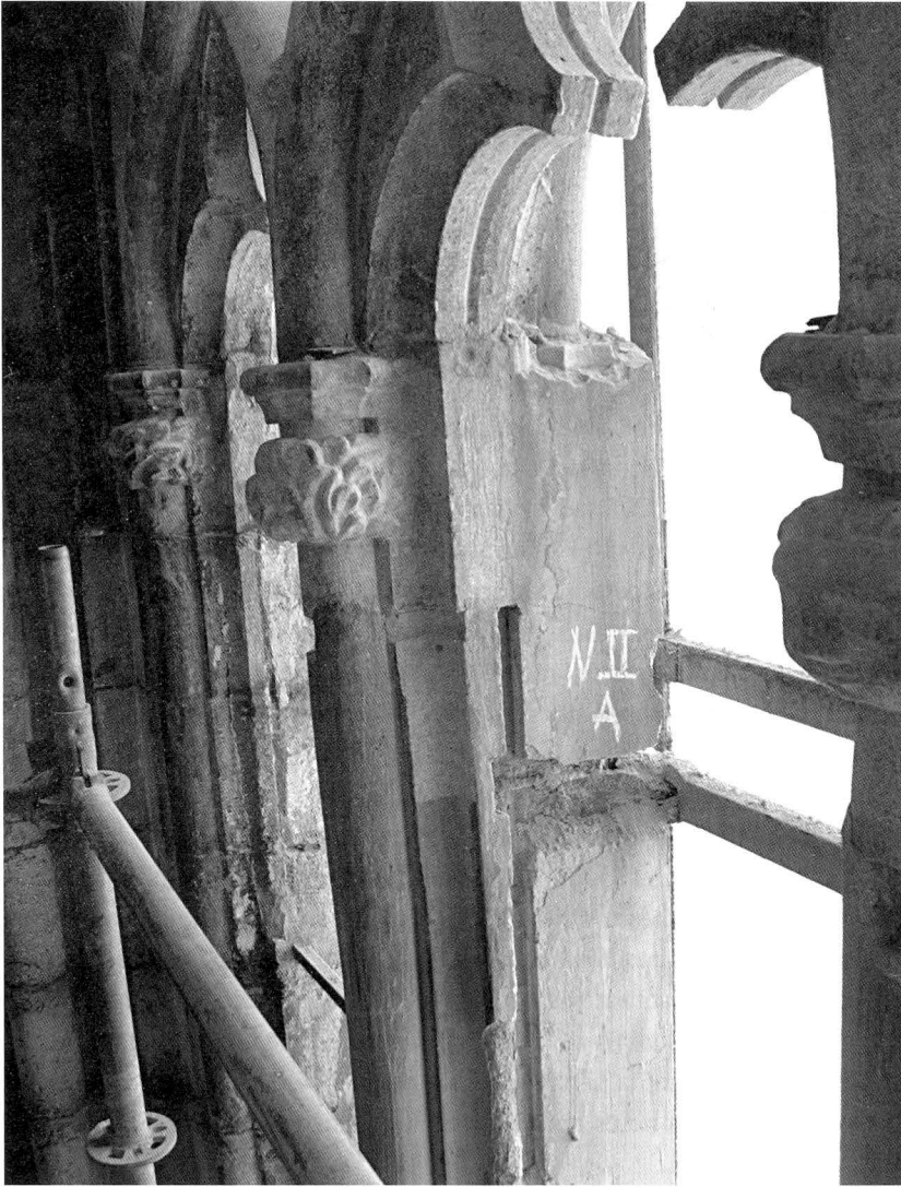
Fig. 9: Mainells d'obra i calats del finestral del mur nord del tercer tram, durant la seva restauració (febrer 2009).
