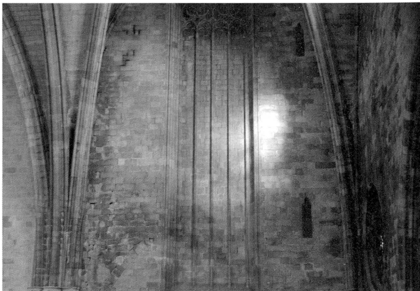
Fig. 4. Fals finestral al mur nord del primer tram (Torre de Carlemany).
