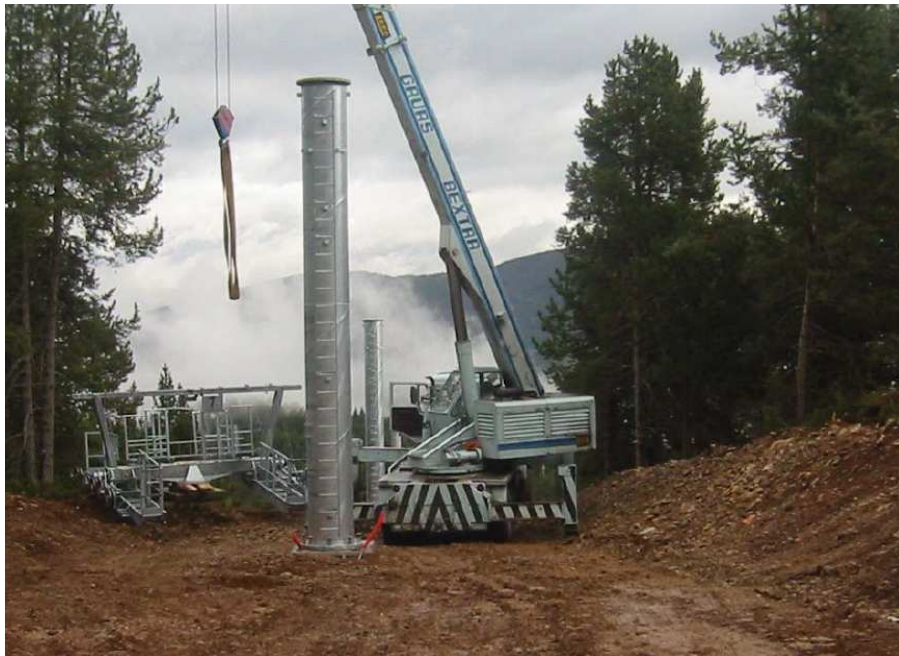
Figura 74: Instal·lació d'un remuntador
