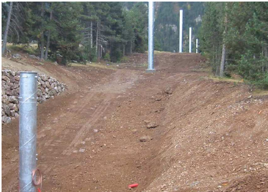
Figura 75: Línia de pilons per un remuntador
