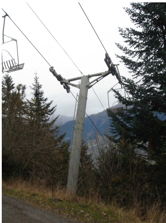
Figura 67: Torre d'un dels remuntadors
