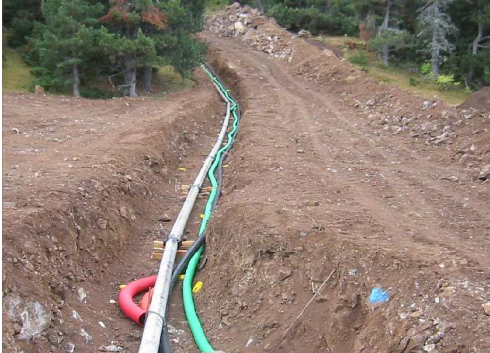
Figura 79: Fotografia de la construcció d'una xarxa de canonades
