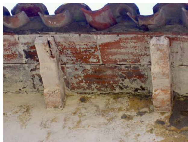
-Colls de formigó armat que l'armadura s'ha oxidat, s'ha inflat i ha acabat petant el formigó
