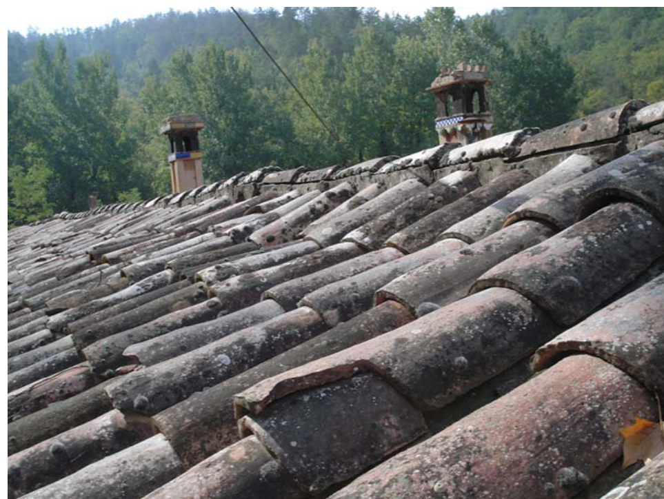
-Vista de la coberta amb algunes teules trencades.
