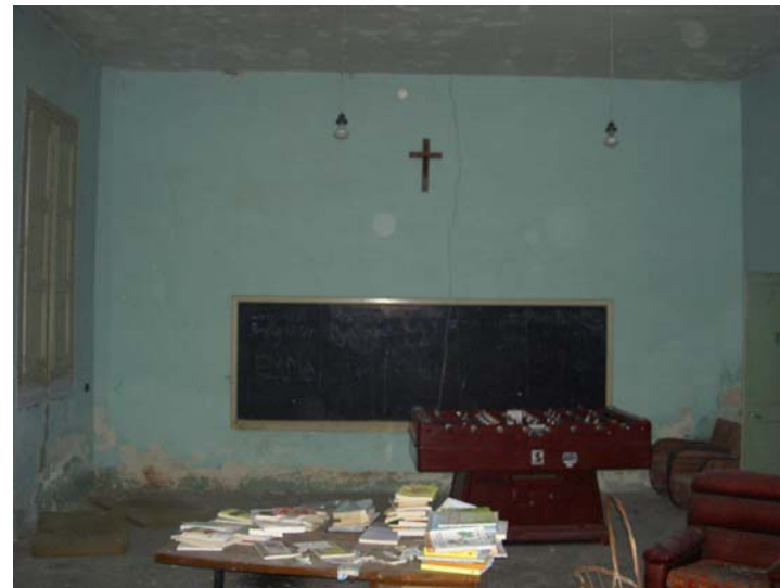
-Vista part interior del mur.
