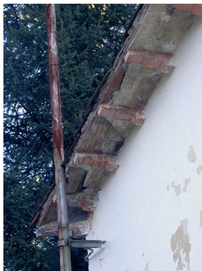
-L'arrebossat del ràfec està bufat i es desprèn amb facilitat
