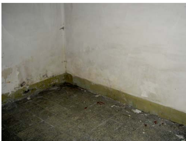
-Humitats en paviment i base mur.
