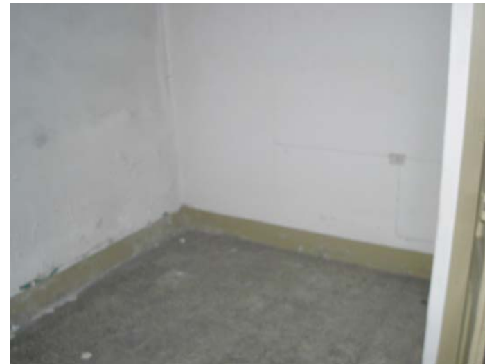
-Vista paviment habitació nord-oest
