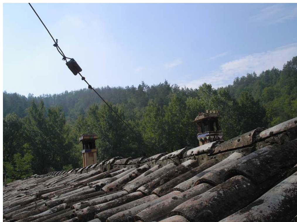
-Vista de la coberta on es poden observar els diferents microorganismes incrustats a les teules.
