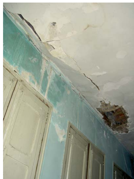
-Humitats en el mur i fals sostre de la zona de l'escola que ha cedit degut a la humitat
