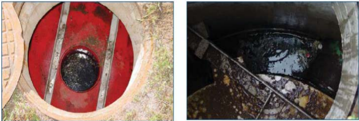
Fig. 7. Vista de eje central para acceso a cámara de sedimentos, izquierda, y zona de acumulación de flotantes y grasas, derecha.
