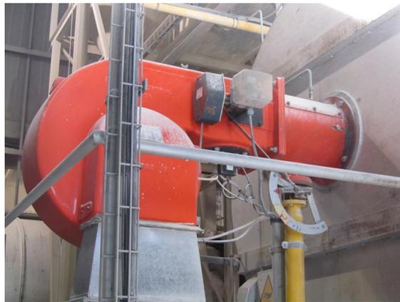
Figura 71. Vista del quemador de gas natural H-2500
