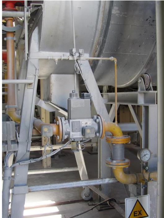
Figura 70. Tren de válvulas del quemador
