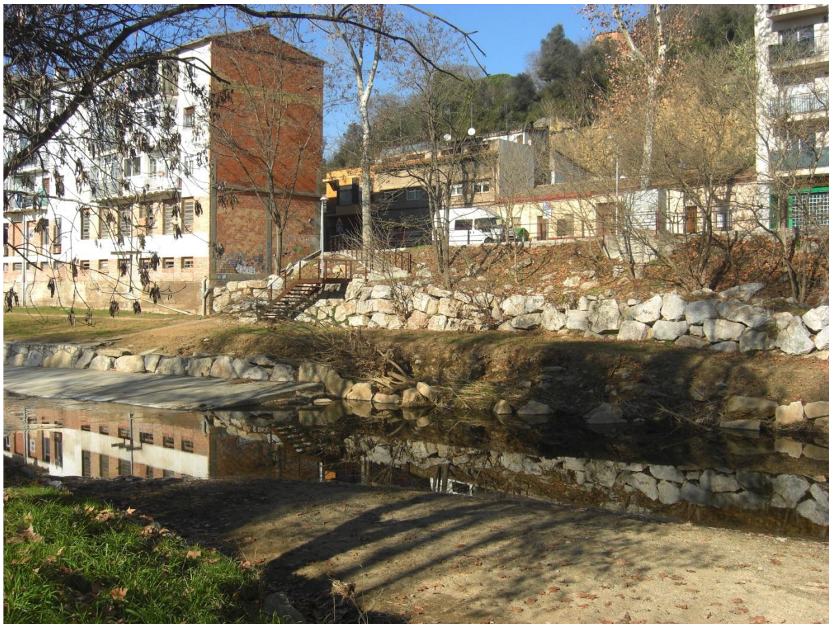
Figura 6: Fotografia número 3 obtenida des del llit del riu on es veu la zona del carrer del Carme i el mur d'escullera que s'ha de desmuntar per fer l'encep a la zona i posteriorment tornar a muntar.
