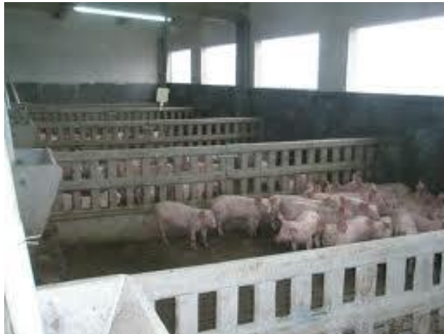
Figura 15. Mur parcial de formigó, facilita la visió i el contacte entre animals.
