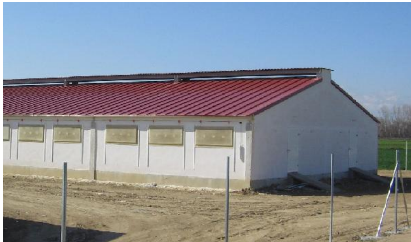
Figura 5. Nau d'engreix de porcs amb cavallet de ventilació.
