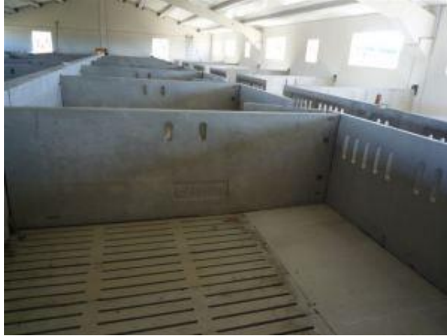
Figura 15. Mur total de formigó, impedeix la visió i el contacte entre animals.
