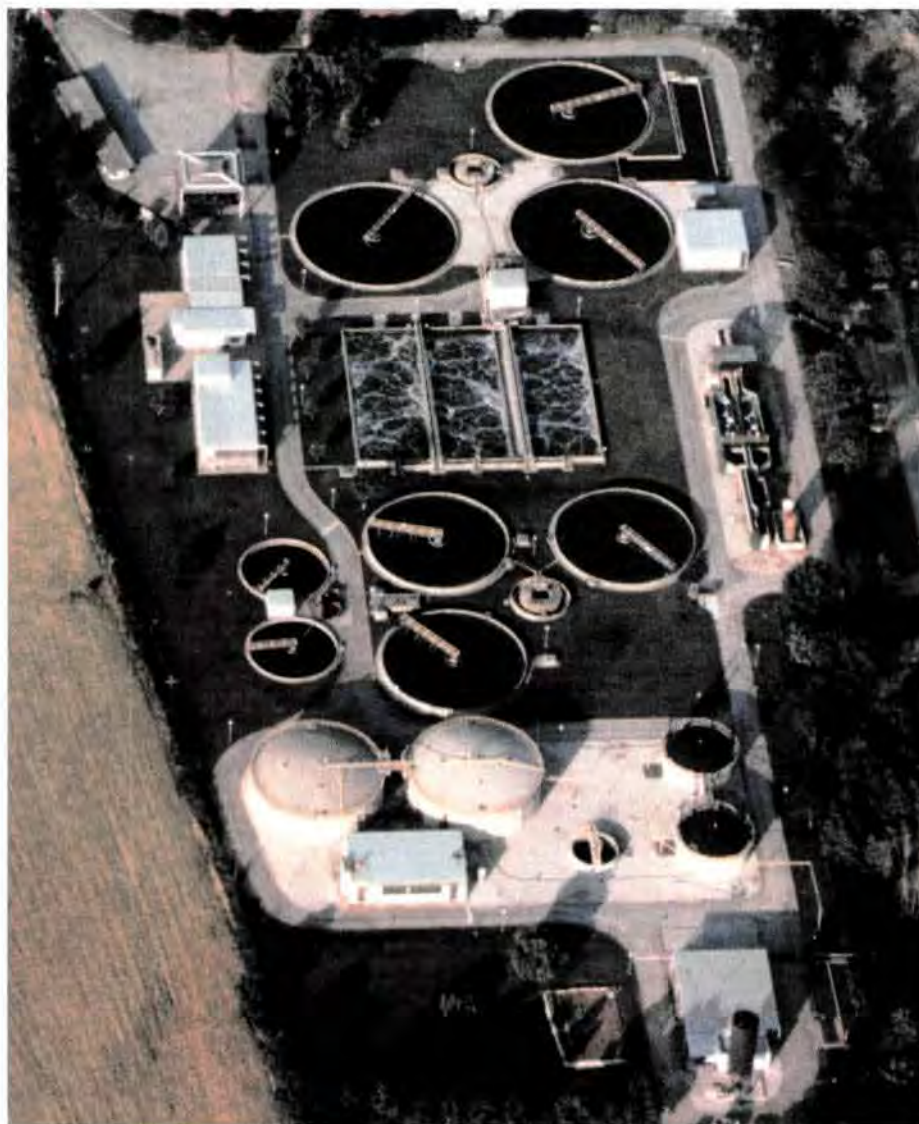
Figura 2.2 Vista aèria de la EDAR de Girona (Foto: J. Carreras)
