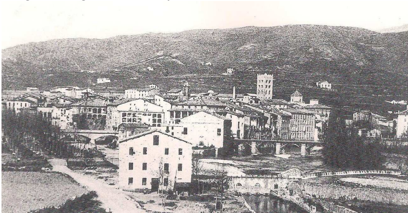
Imatge 12: Imatge de la vila de Ripoll.
