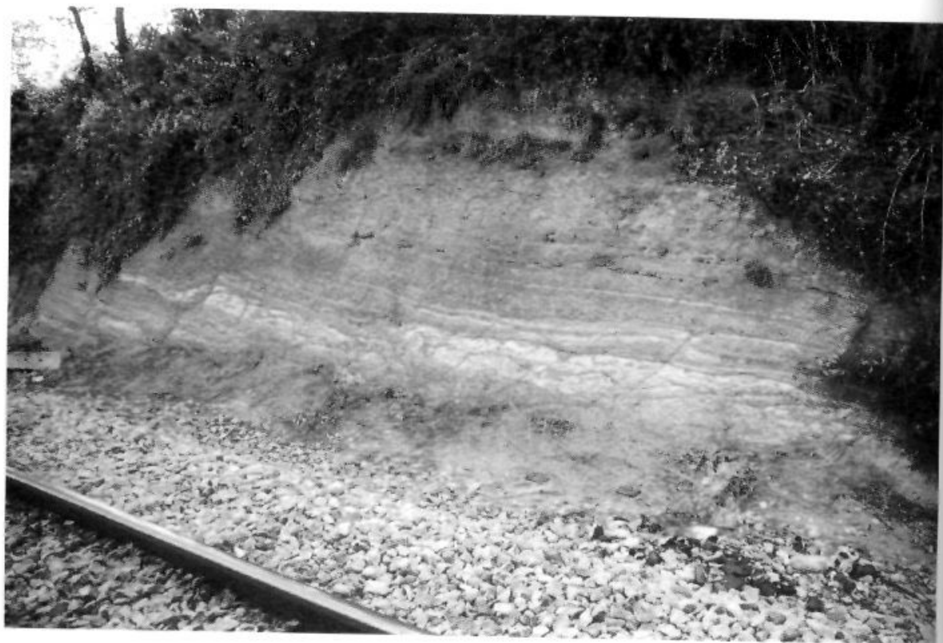
Seqüència de dipòsits piroclàstics en un talús de la via del tren.
